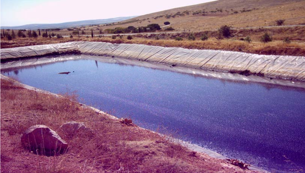
Resim 4: Katı Atık Bertaraf Tesisi Sızıntı Suyu Lagünü
