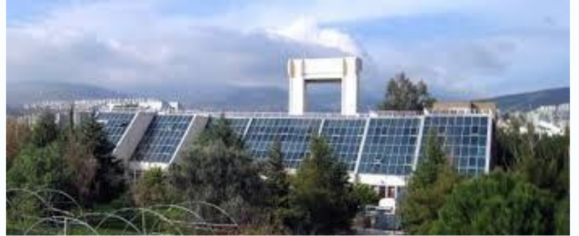
Ege Üniversitesi Güneş Enerjisi Enstitüsü
