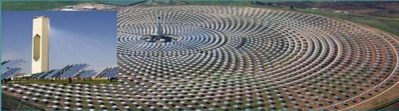
Heliostat sistemler toplacı - Güneş kulesi
