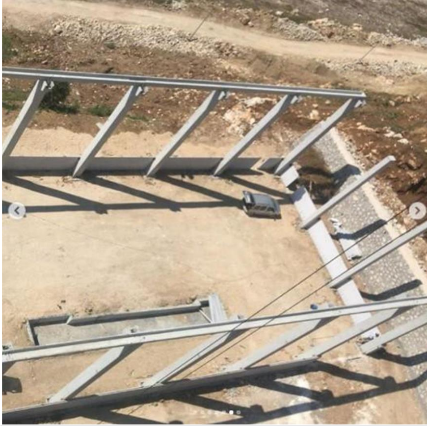
Resim 7: Ayrıştırma Ünitesi Prekast Kolon İmalatı
