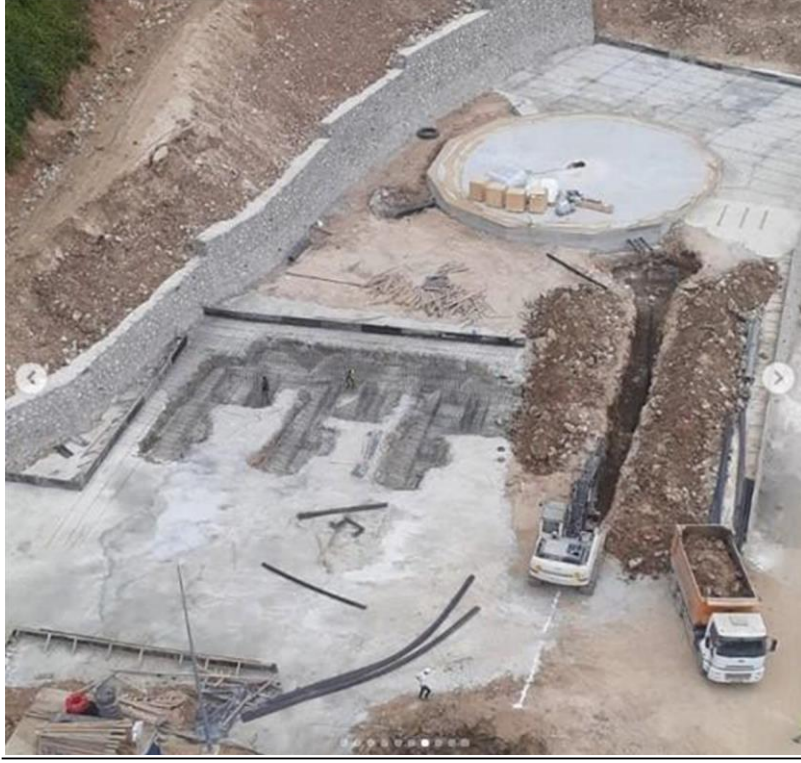
Resim 4: Kojenerasyon Ünitesi ve Gaz Balonu Temeli
