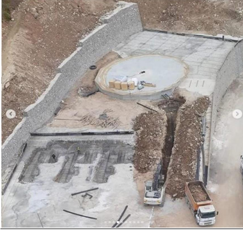
Resim 6: Kojenerasyon Ünitesi ve Gaz Balonu Temeli
