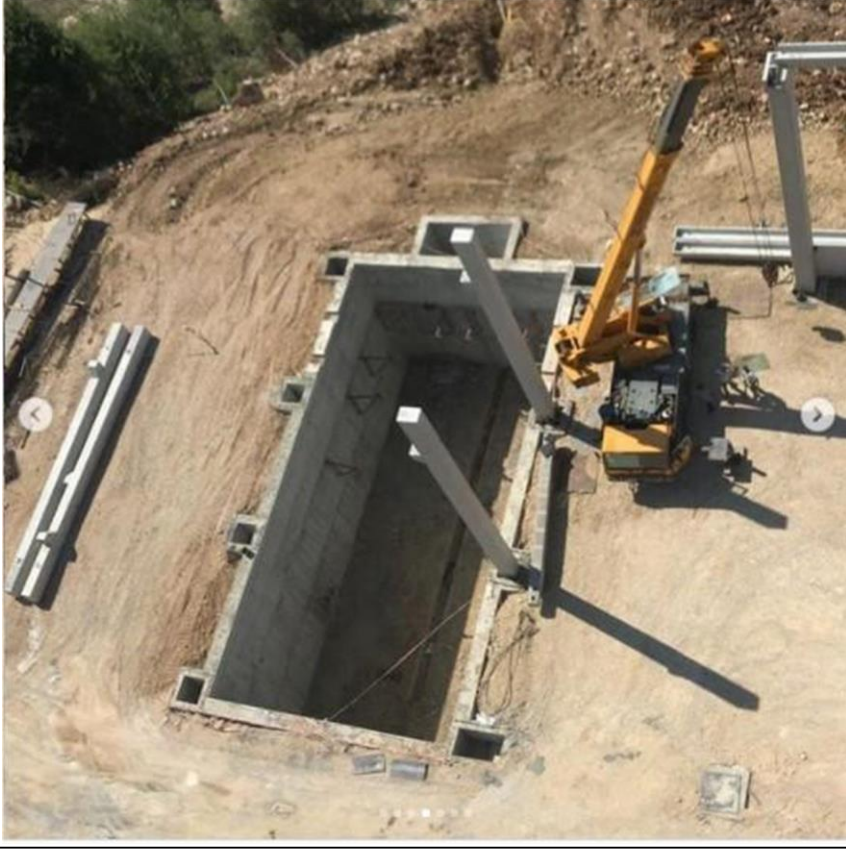
Resim 8: Ayrıştırma Binası Atık Kabul Çukuru Temeli
