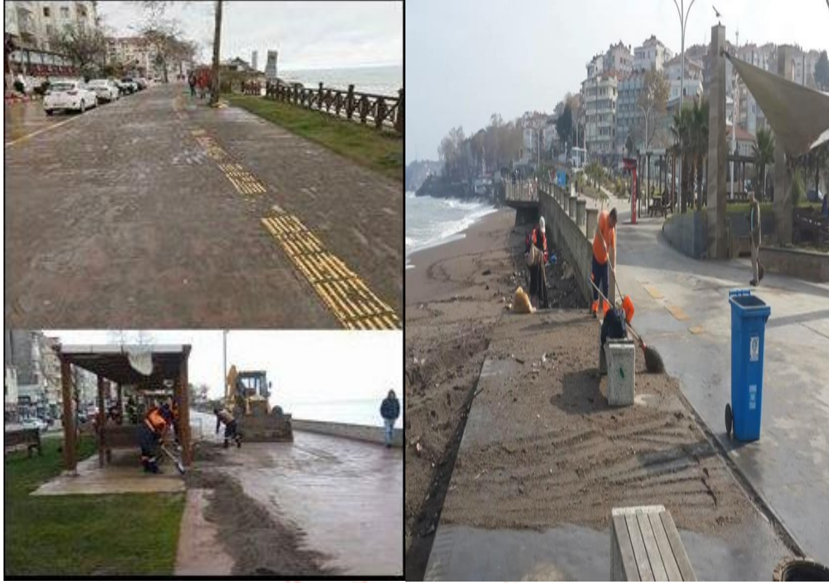
Fotoğraf 5: Akçakoca İlçesinde yürüyüş yolunda yapılan temizlik çalışması
