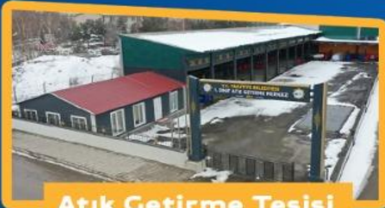
Atık Getirme Tesisi
