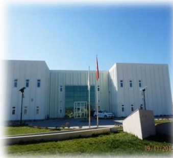
Yapı Malzemeleri Laboratuvarı
