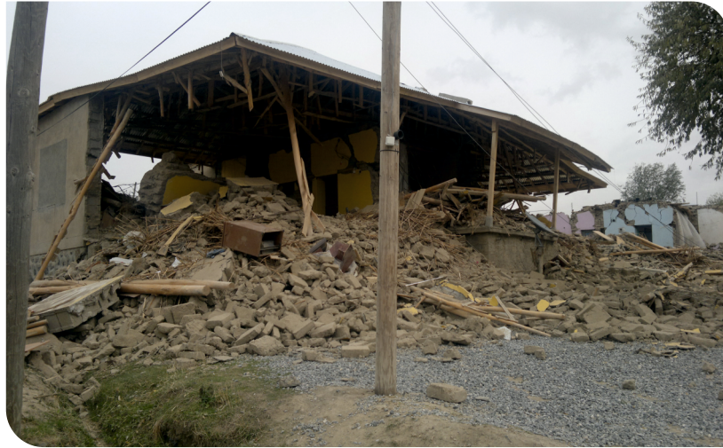
Tabanlı Köyünde içinde can kaybı olan, taşıyıcı duvarları kerpiç ve moloz taşlı, çatısı toprak damlı göçük yapı
