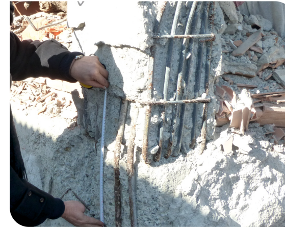
Zayıf bağlantı. Perdeye bağlanan kiriş ayrılmış. Uygun olmayan donatı yerleşimi. Kirişten gelen donatıların uçları gönye şeklinde kıvrılmadan kanca yapılmış. Bu Okul binasında hem proje, hem de imalat hataları gözlenmiştir (Gedikbulak İ.Ö.O.)
