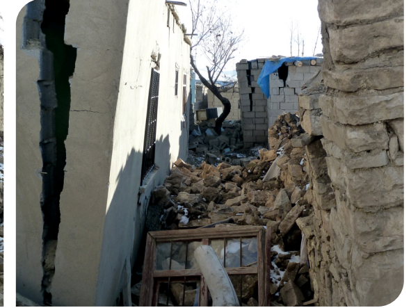
Vanda bitişik nizam yapılmış kerpiç binalar. Rijit diyafram özelliği olmayan, tek yönlü olarak merteklerle teşkil edilmiş ve duvarlara yeterince mesnetlenmemiş tavan döşemeleri ve oturma çatılar. Uzun mesnetlenmemiş dış duvarlar kolaylıkla düzlem dışına yıkılmış
