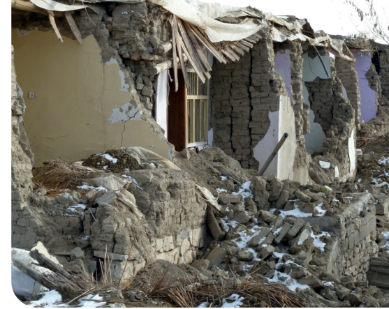
Vanda bitişik nizam yapılmış kerpiç binalar. Rijit diyafram özelliği olmayan, tek yönlü olarak merteklerle teşkil edilmiş ve duvarlara yeterince mesnetlenmemiş tavan döşemeleri ve oturma çatılar. Uzun mesnetlenmemiş dış duvarlar kolaylıkla düzlem dışına yıkılmış
