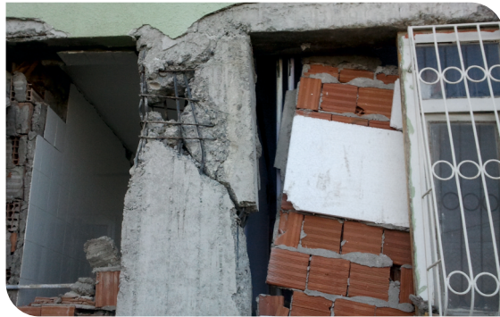
Kolonda kesme kırılması
