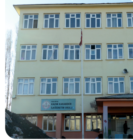
Zemin +3 katlı taşıyıcı sistemi betonarme çerçeveli bina. 2007 yılında taşıyıcı sisteme çerçeve düzlemi içine betonarme perdeler ilave edilerek güçlendirilmiş
