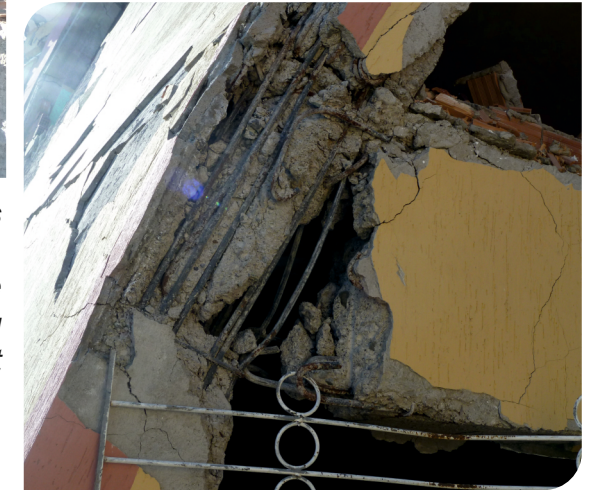
Zayıf bağlantı. Perdeye bağlanan kiriş ayrılmış. Uygun olmayan donatı yerleşimi. Kirişten gelen donatıların uçları gönye şeklinde kıvrılmadan kanca yapılmış. Bu Okul binasında hem proje, hem de imalat hataları gözlenmiştir (Gedikbulak İ.Ö.O.)
