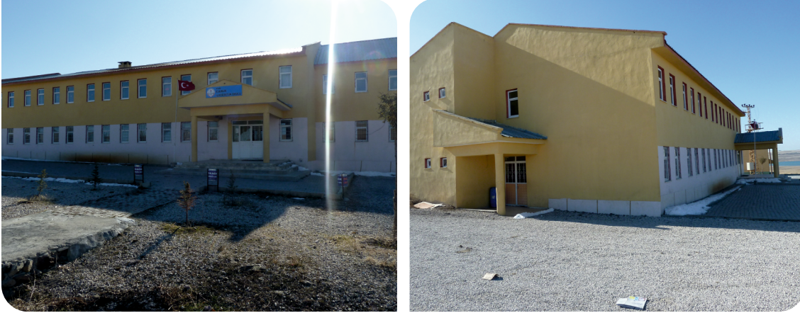
Van-Erciş yolu üzerindeki Canik Köyü İlköğretim Okulunda hiç hasar yok
