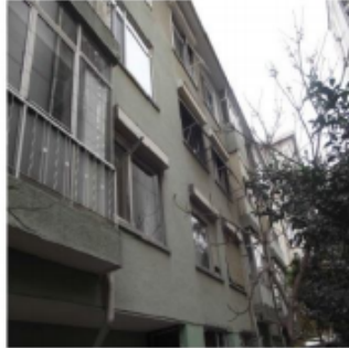
SAĞ YAN CEPHE
