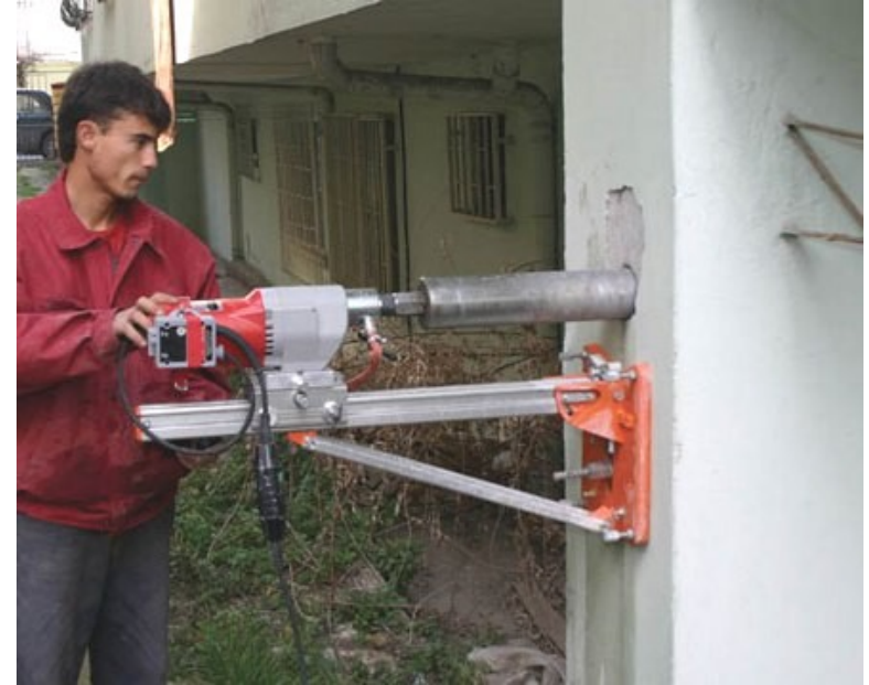
Karot alma cihazı ile kolondan silindirik beton örneği alınması
