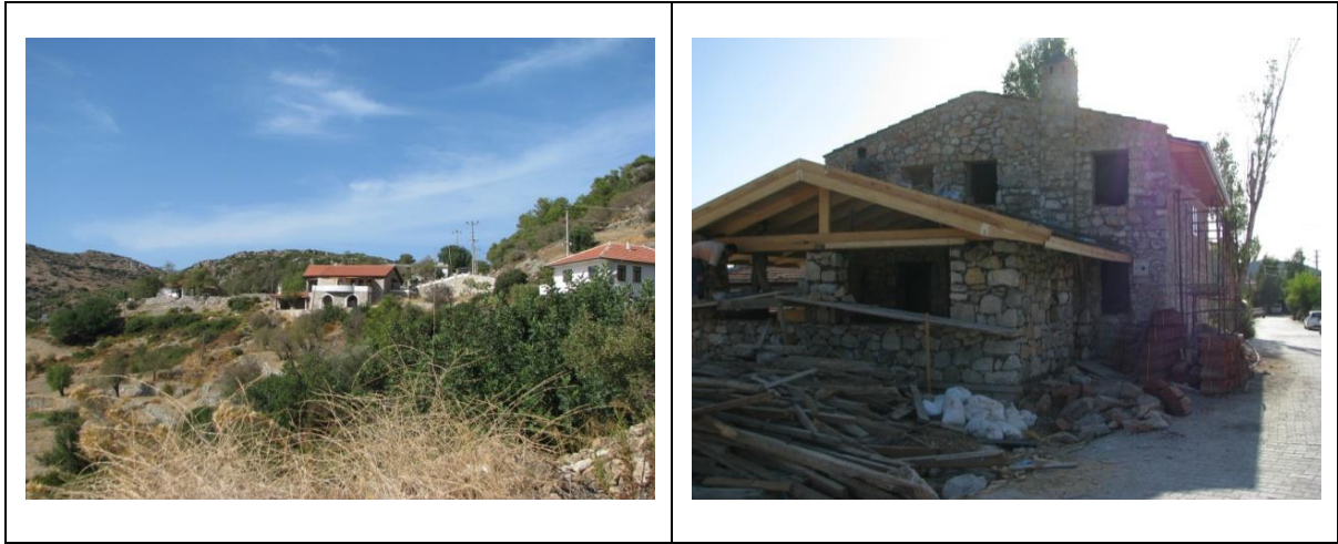
Fotoğraflar 4.1.1.3.2. Söğüt Yerleşimi ve Restore Edilen Binalar
