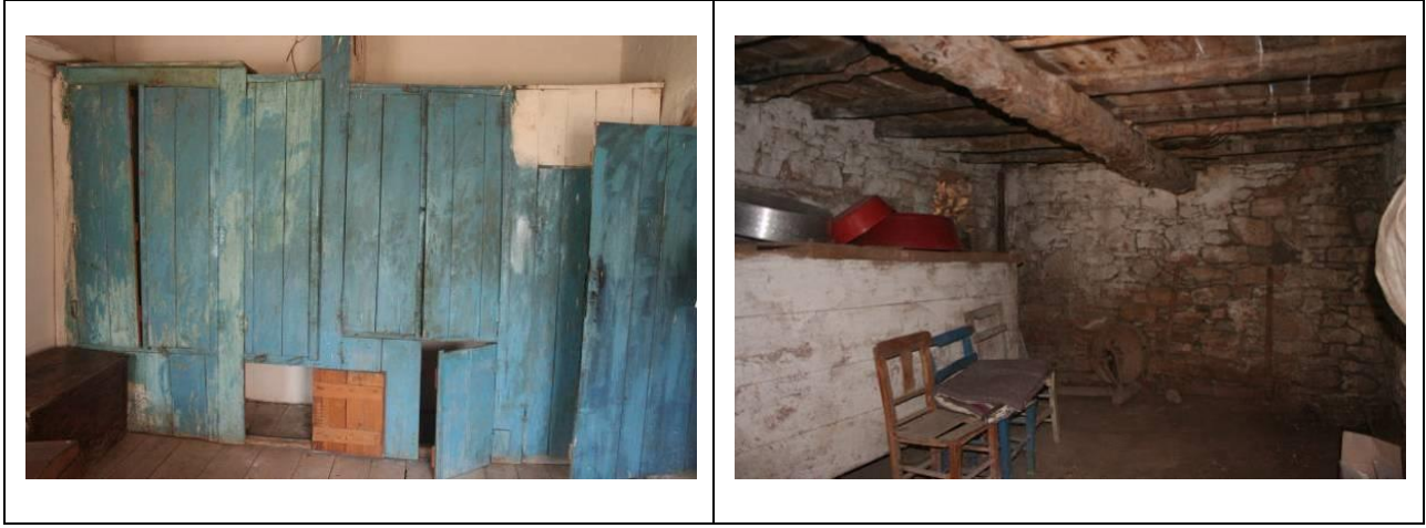
Fotoğraflar 4.2.2.3.5. 1 No’lu Mekanda Dolap ve Gusûlhane ve Yapının Zemin Katındaki Depo Mekanı
