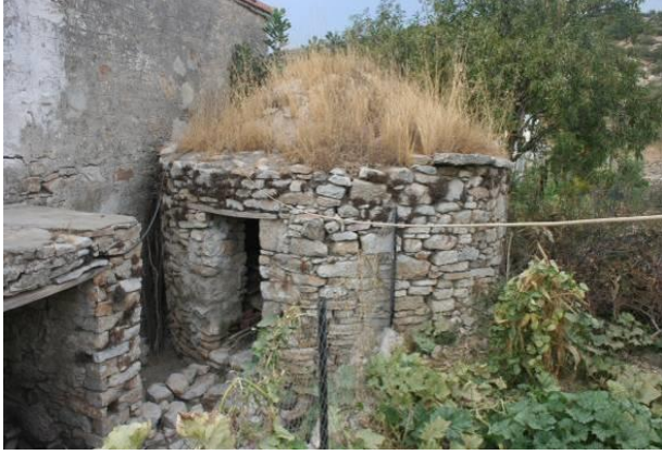
Fotoğraflar 4.2.2.3.12. 8 No’lu Envanter Yapısına Bitişik Bulunan Dairesel Planlı ve Taş Kubbeli Yapı
