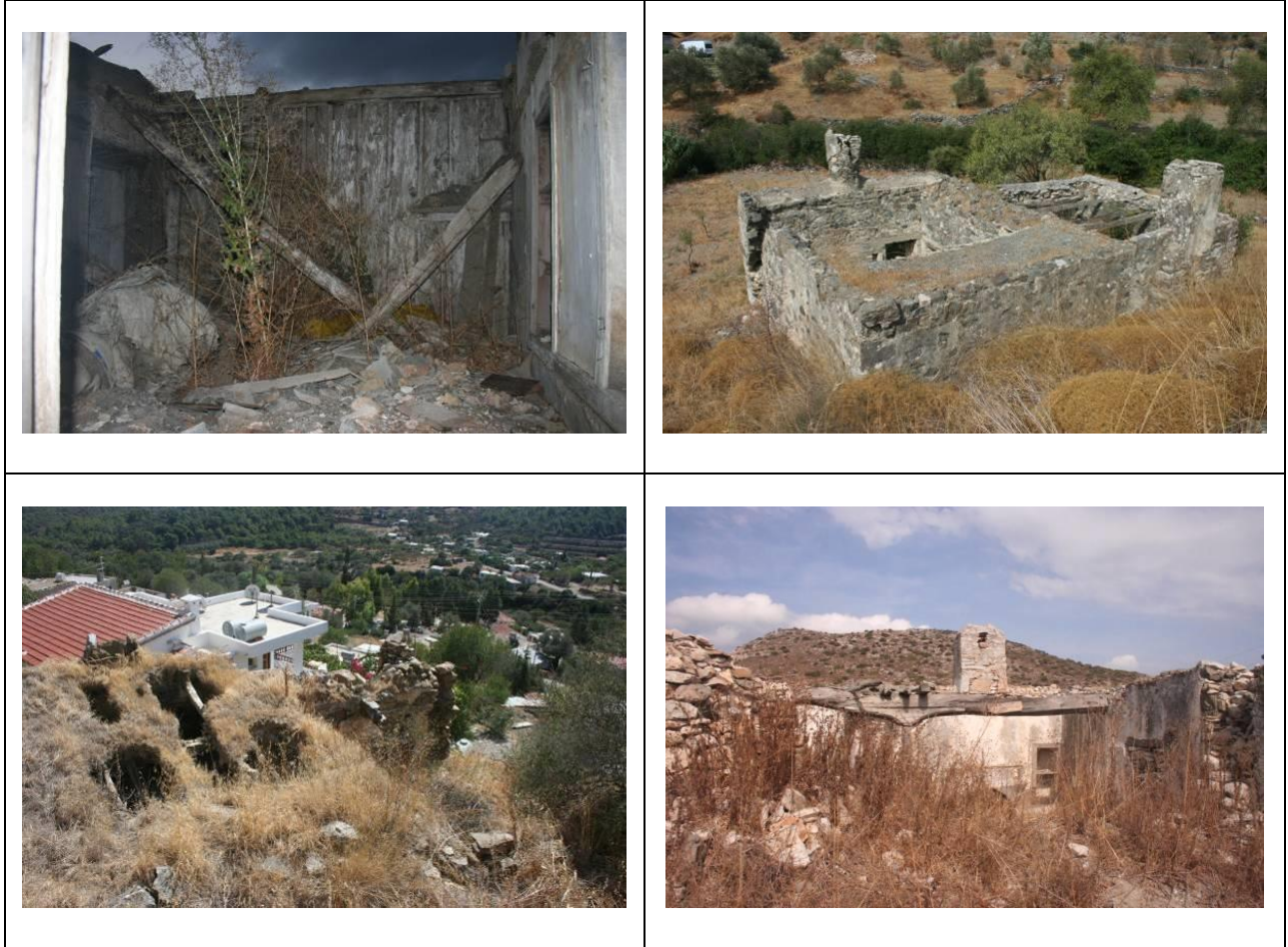
Fotoğraflar 5.2.2.2.1.1. Reşadiye, Sındı, Emecik ve Belenköy’den Üst Yapısı Yok Olmuş/Olan ve Ciddi Çökme Tehlikesi Bulunan Geleneksel Düz Damlı Örnekler
