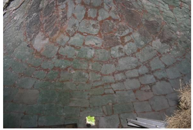
Fotoğraflar 4.2.2.3.12. 8 No’lu Envanter Yapısına Bitişik Bulunan Dairesel Planlı ve Taş Kubbeli Yapı
