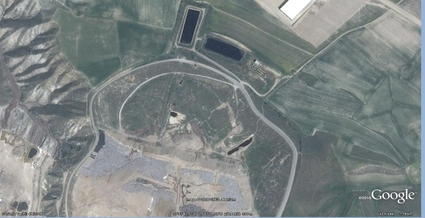
Kumkısıık Katı Atık Bertaraf Tesisi
