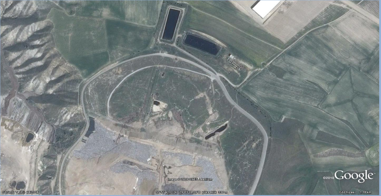
Kumkısıp Katı Atık Bertaraf Tesisi
