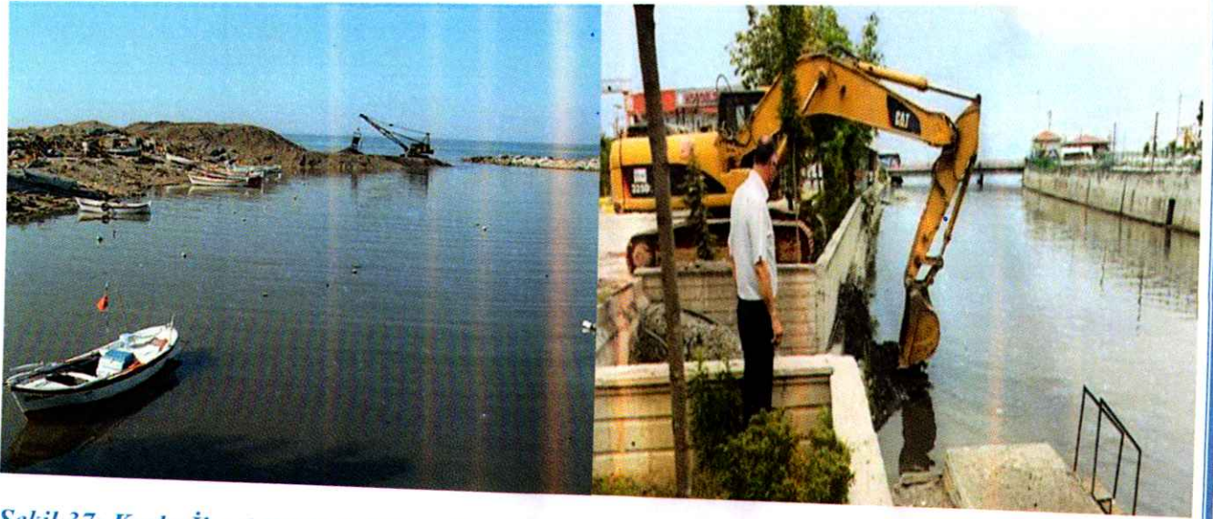
Şekil 37: Kozlu İlçesi Kozlu Dereağızı Temizliği
