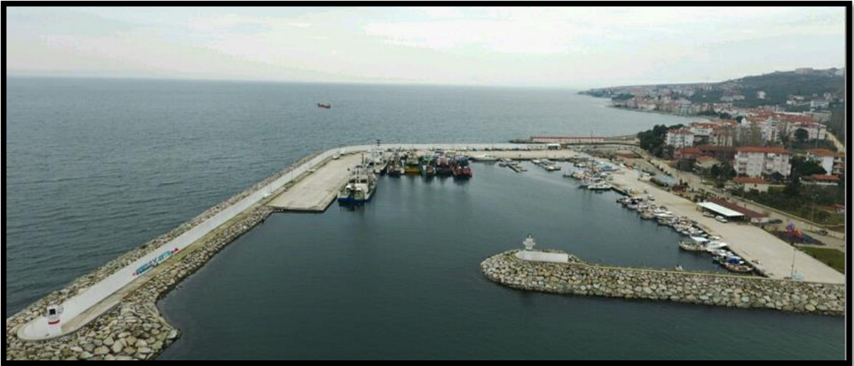
Fotoğraf 18: Armutlu Liman Mevkii Balıkçı Barınağı
