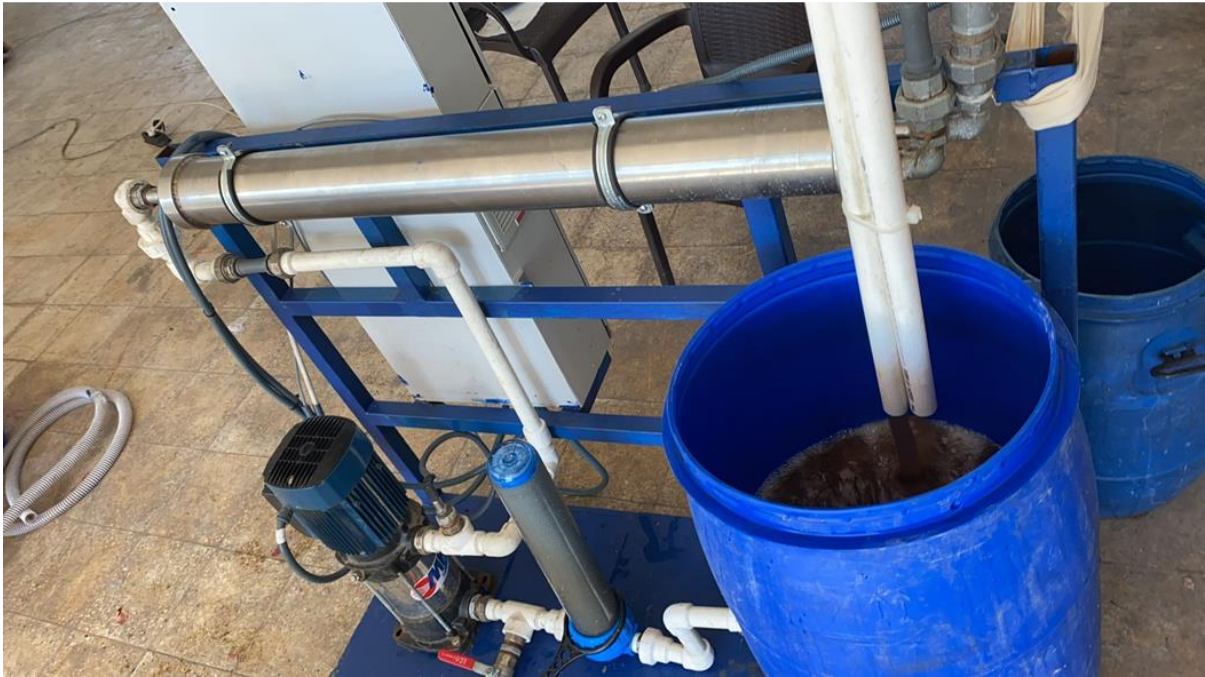
Şekil 10. Pilot ölçekli EO+AK+NF membran arıtma tesisi
