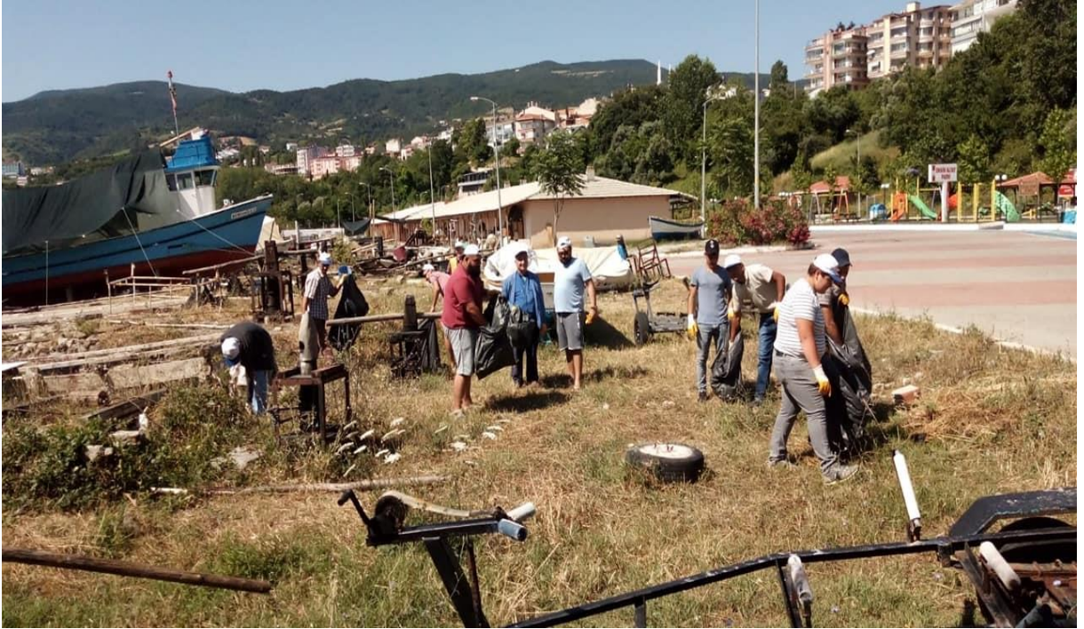
Şekil:92 Sinop Gerze İlçesi Kaya Temizliği
