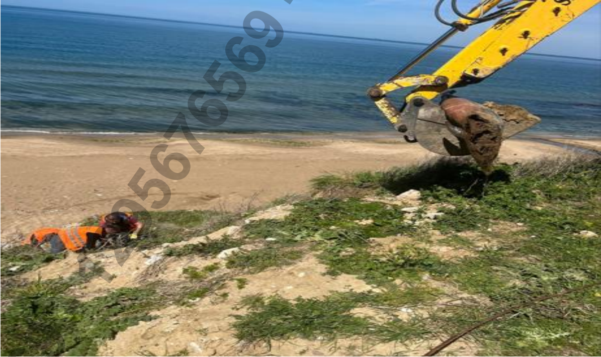
Şekil :92 Sinop İli, Merkez İlçesi Stad Arkası Kayalıklarda Temizlik Çalışmaları
