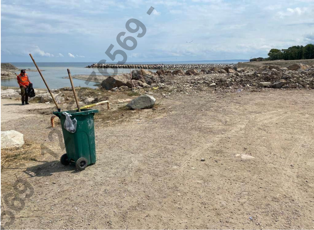
Şekil : 51 Sinop Ayancık İlçesi Ayancık Çayı Denize dökülen alanlarda çalışmalar
