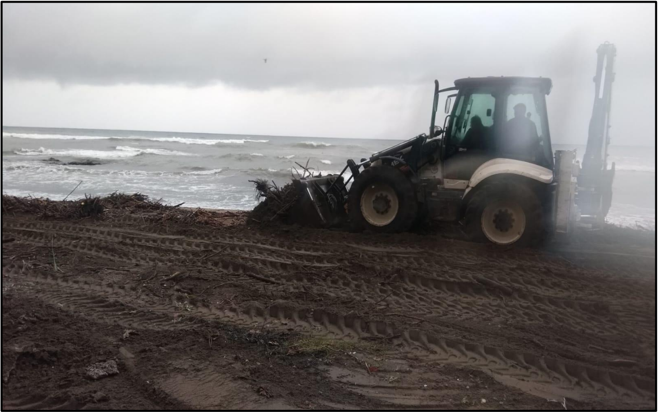
Resim 5.1: Fatsa İlçesi Temizlik Çalışmaları
