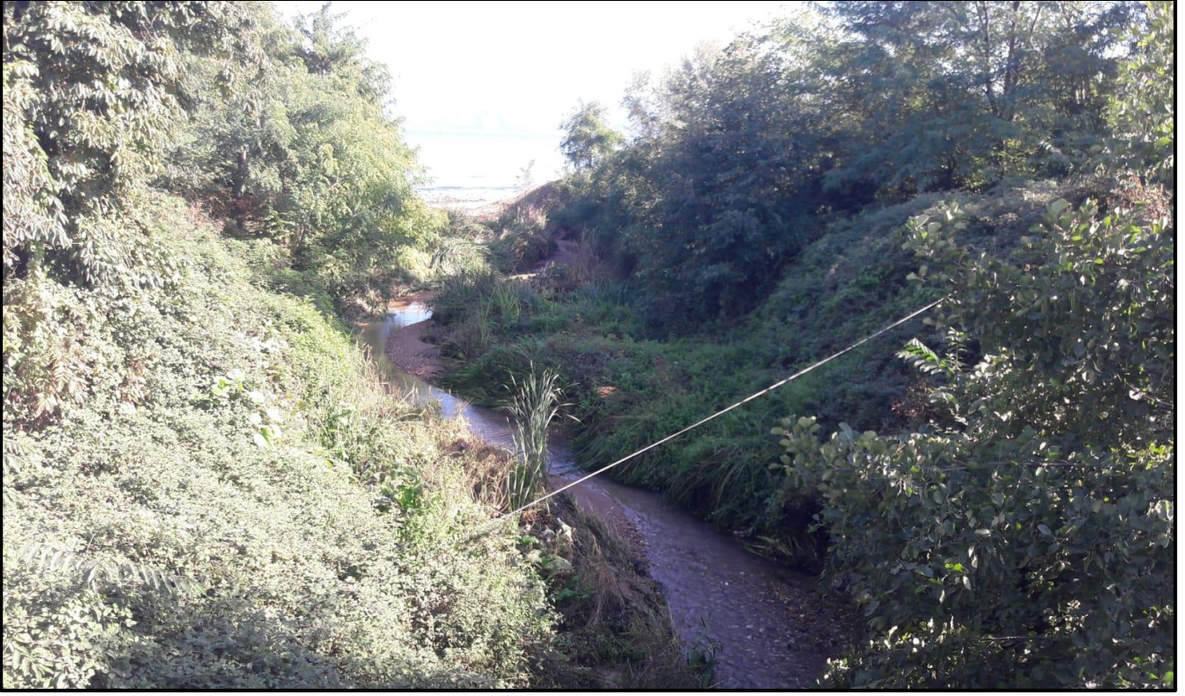
Resim 5.4: Dolunay Yapraklı Deresi Ağzı Mansap Kısmı Temizlik Çalışmaları
