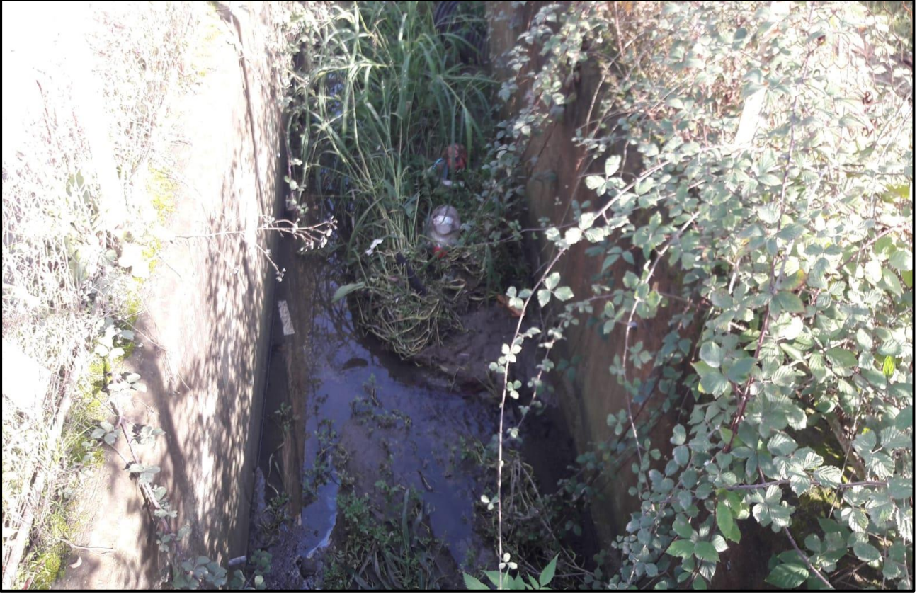
Resim 5.6: Fatsa İlçesi Temizlik Çalışmaları
