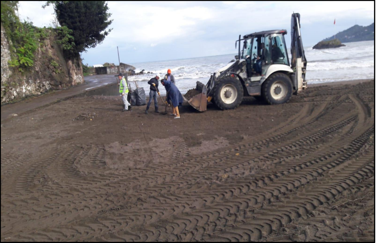
Resim5.13: Fatsa İlçesi Bolaman Mah. Haznedaroğlu Konağı Önü Temizlik Çalışmaları
