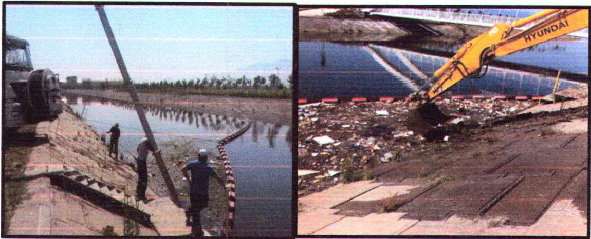
Şekil 6: Bariyer Temizleme Çalışmaları
