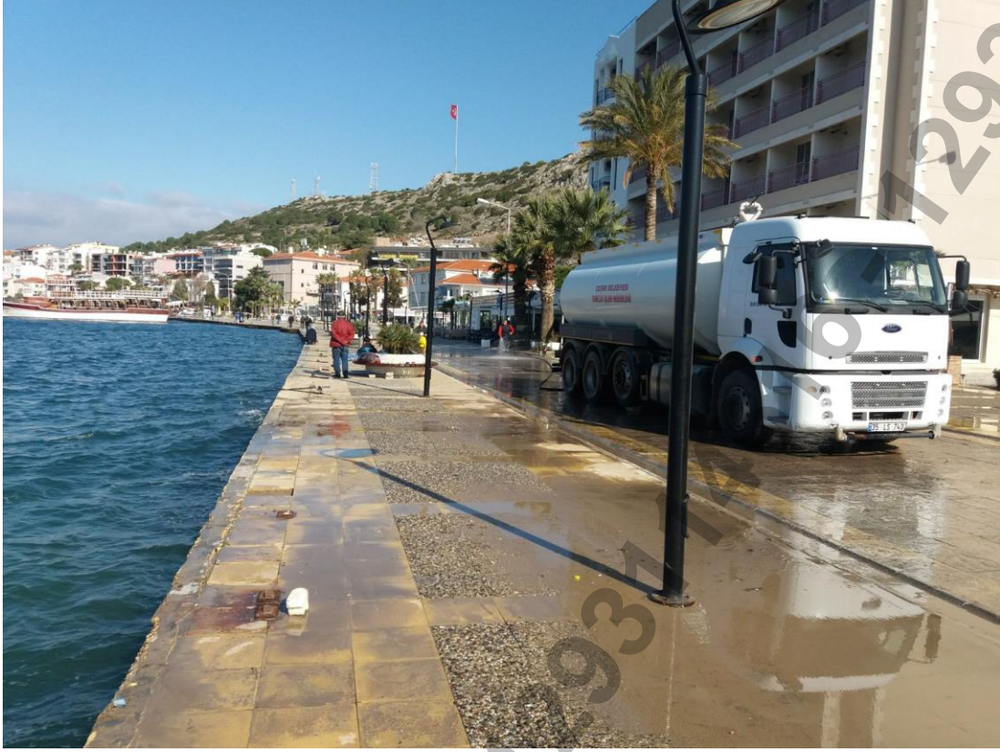
Şekil 11. Çeşme Belediyesi yürüyüş yolları temizleme çalışmaları
