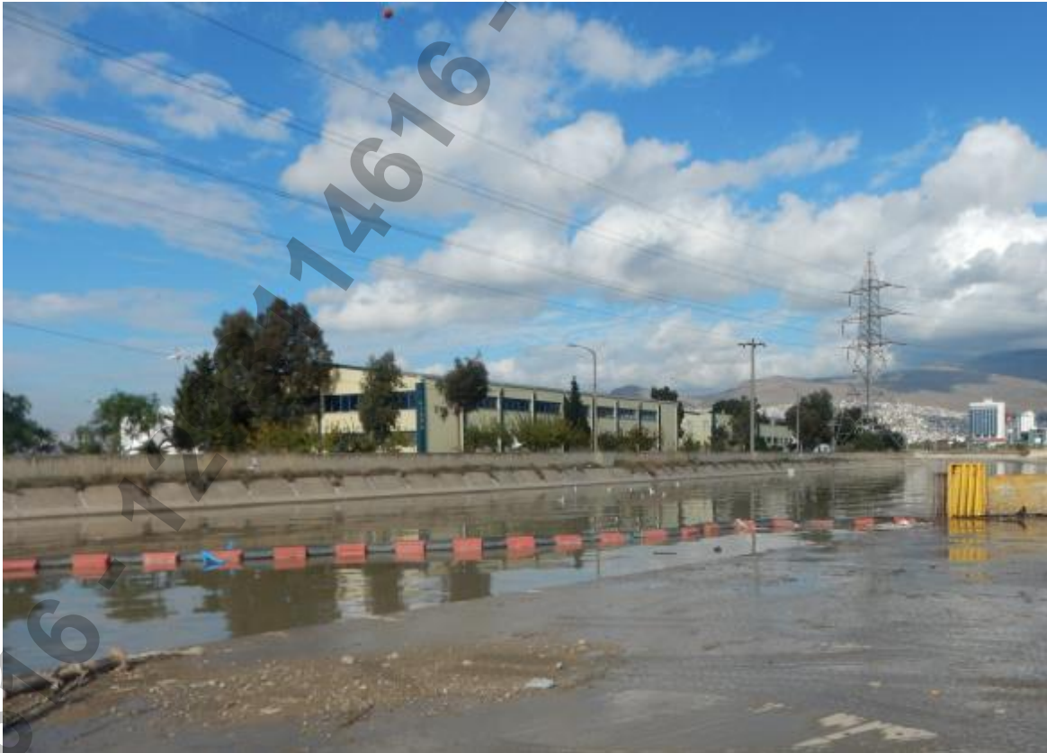
Şekil 27. Konak İlçesi Meles Deresi Bariyer Önü Temizlik Çalışmaları Sonrası
