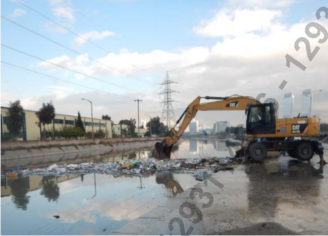
Şekil 26. Konak İlçesi Meles Deresi Bariyer Önü Temizlik Çalışmaları Anı
