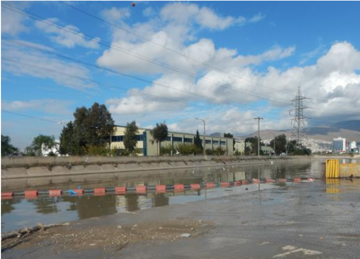
Şekil 23. Konak İlçesi Meles Deresi Bariyer Önü Temizlik Çalışmaları Sonrası
