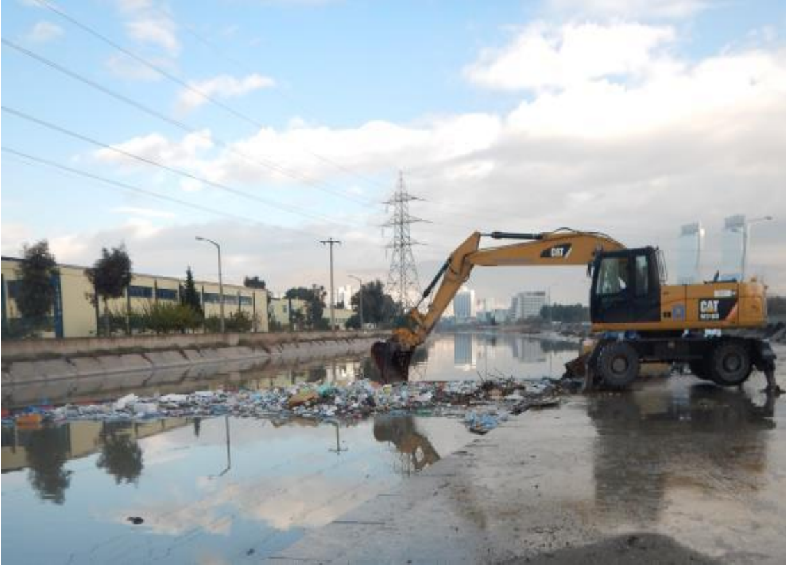
Şekil 22. Konak İlçesi Meles Deresi Bariyer Önü Temizlik Çalışmaları Anı
