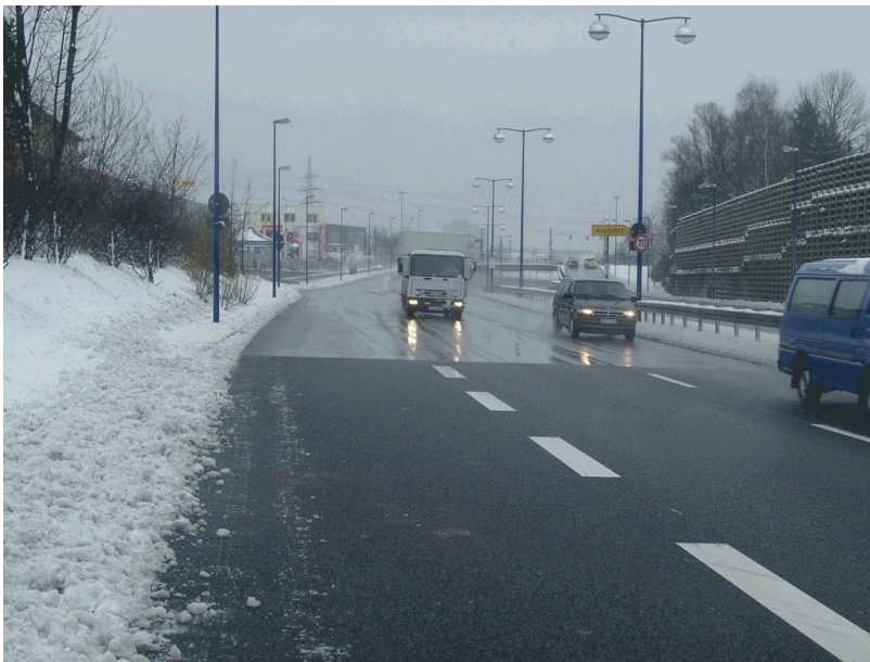
Resim B-6: Kapalı bir taşıt yolu kaplamasından açık gözenekli asfalta geçiş
