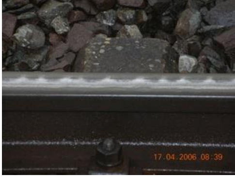
Resim 4 -11: Oluklu raylar (dalga biçiminde açık gri renkli desen)
