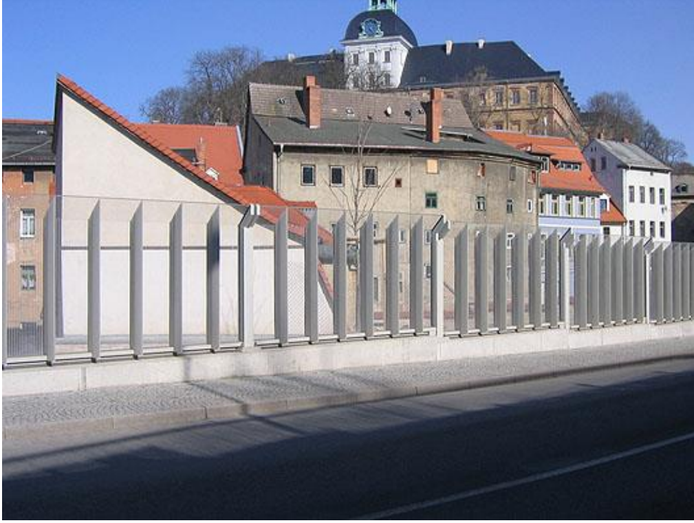
Resim 7-13: Ses absorbe eden özelliklere sahip bir cam perde (Foto R.Kohlhauer GmbH)
