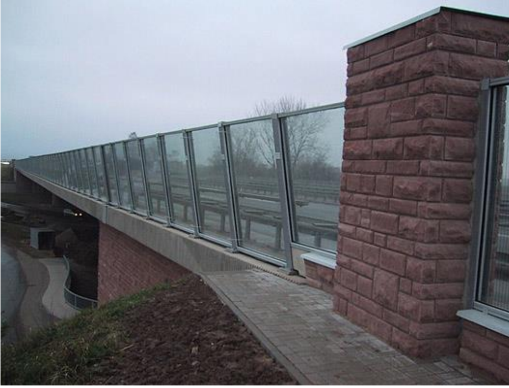
Resim 7-10: Bir köprü üzerinde dışa doğru eğik cam perde (Foto R.Kohlhauer GmbH)
