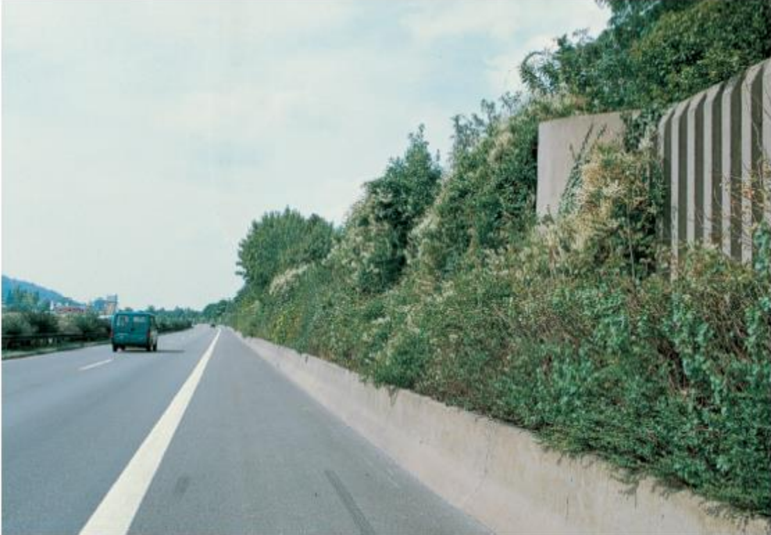
Resim A-3: Fide yastıkları kullanılarak yeşillendirme için yaratılan uygun çevre şartları
