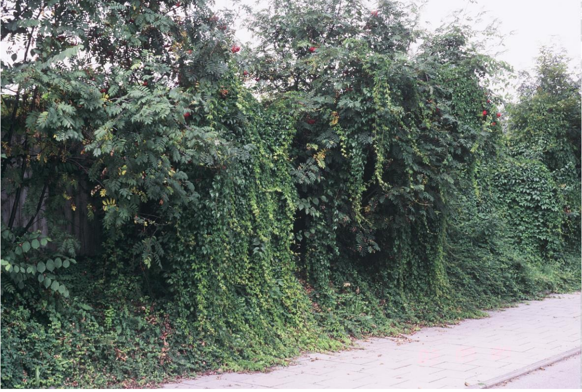
Resim A-2: Bir beton perdenin yoğun biçimde yeşillendirilmesi
