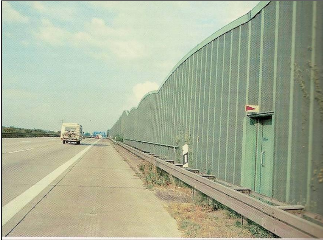
Resim 7.-16: Uzun bariyerlerde acil çıkış kapısı
