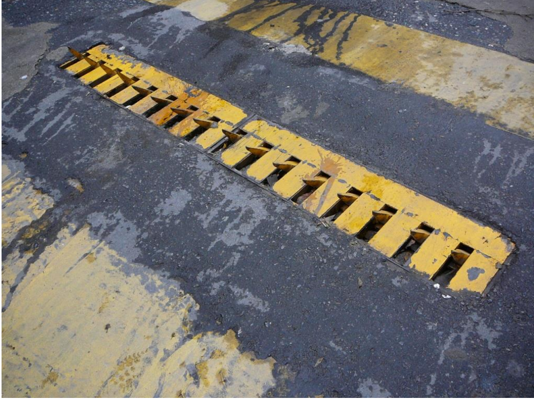
Resim 3-16: İstanbul’da bir geçiş yönünü kapatmak için “yer tuzağı” (kapan)
