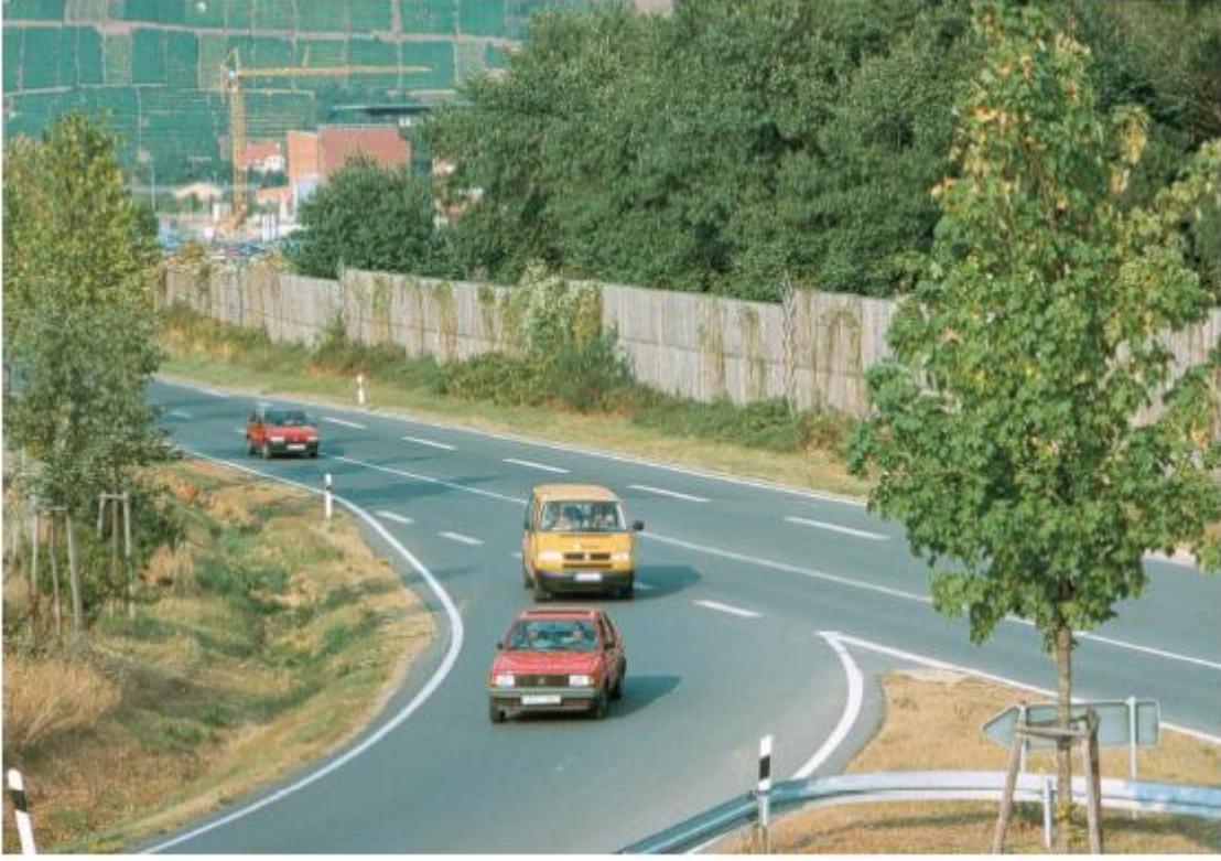
Resim A-14: Duvar üst kenarının basamaklandırılması
