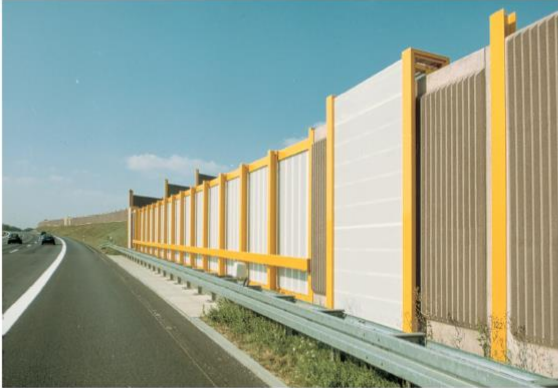
Resim A-23: Bir köprü üzerinde yer alan alüminyum bir perde
