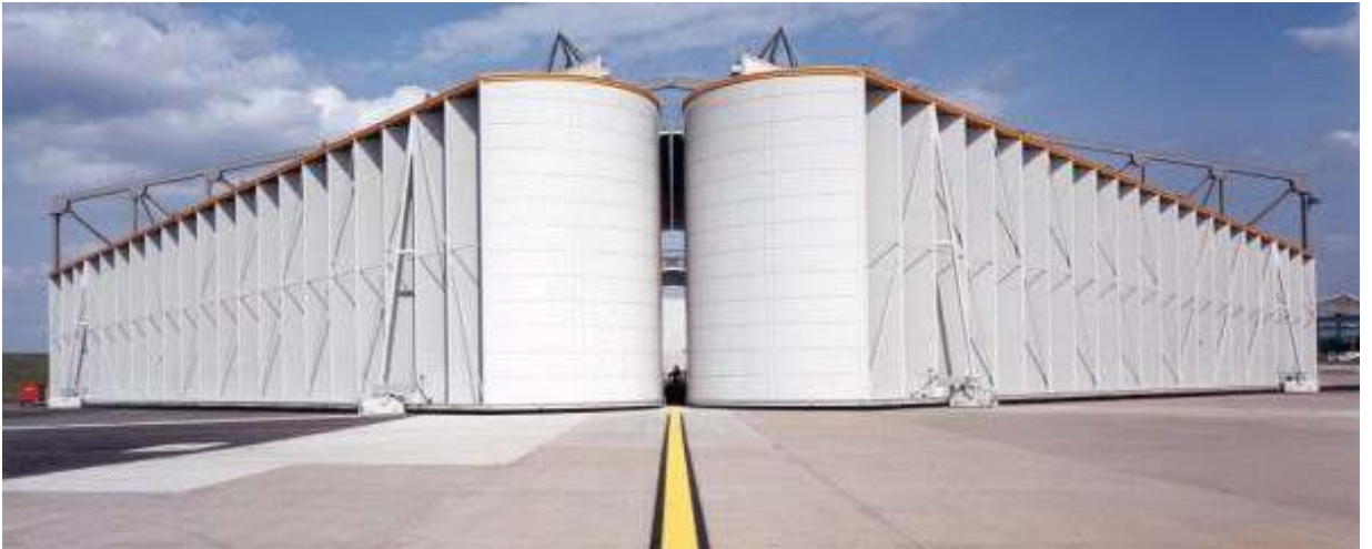
Resim 5-53: Hamburg-Fuhlsbüttel Hava Limanındaki gürültü hangarı (hangar kapısı kapalı)
