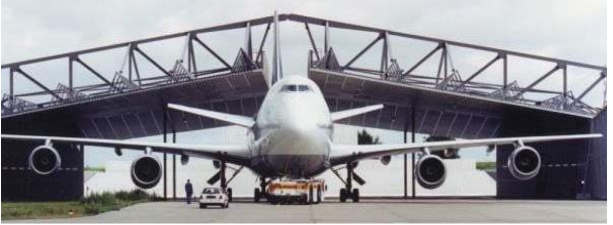
Resim 5-52: Hamburg-Fuhlsbüttel Hava Limanındaki gürültü hangarı (hangar kapısı açık)
