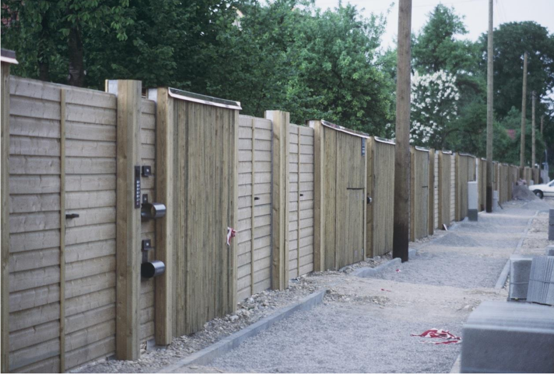
Resim B-2: Bir gürültü perdesinin trafiğe açılması ile kesintiye uğraması
