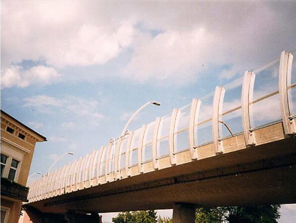
Resim 7-11: Bir köprü üzerinde eğik cam perde (Foto R.Kohlhauer GmbH)
