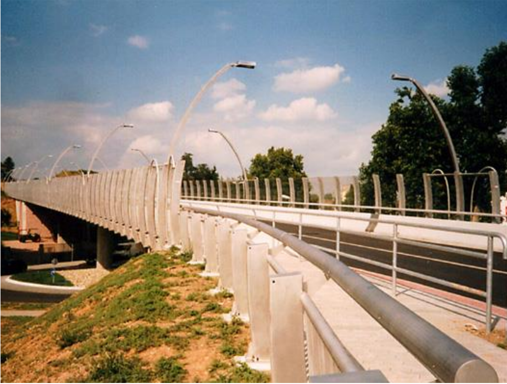
Resim 7-12: Bir köprü üzerinde eğik gürültü perdeleri (Foto R.Kohlhauer GmbH)
