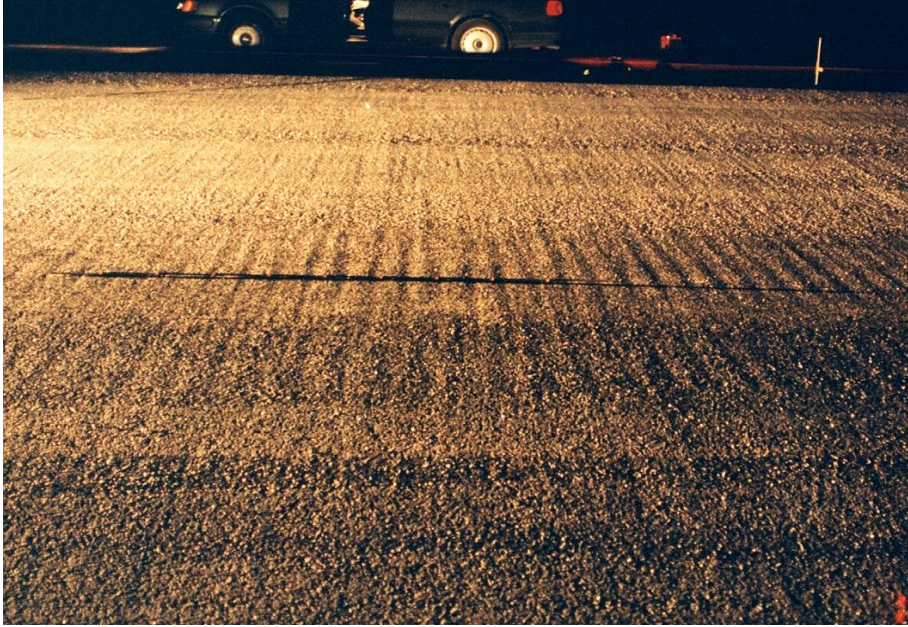
Resim B-10 : Bir agregalı mastik kaplamanın hatasız olarak yapımı
