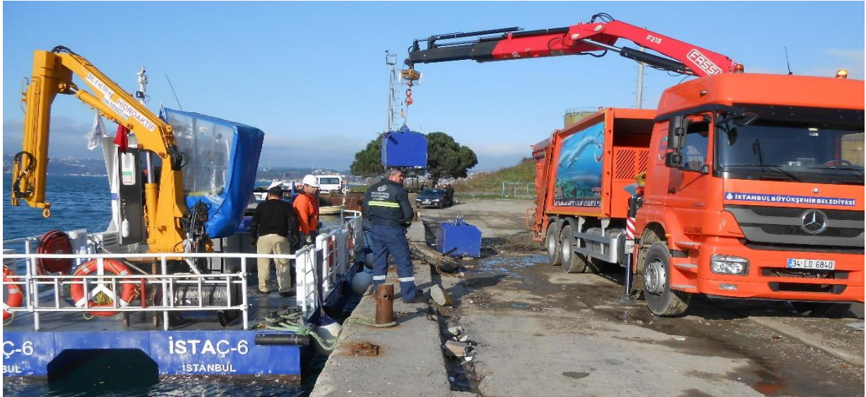
Şekil 35: Vinçli Atık Toplama Aracı İle Deniz Çöpü Toplama Çalışması (1)
