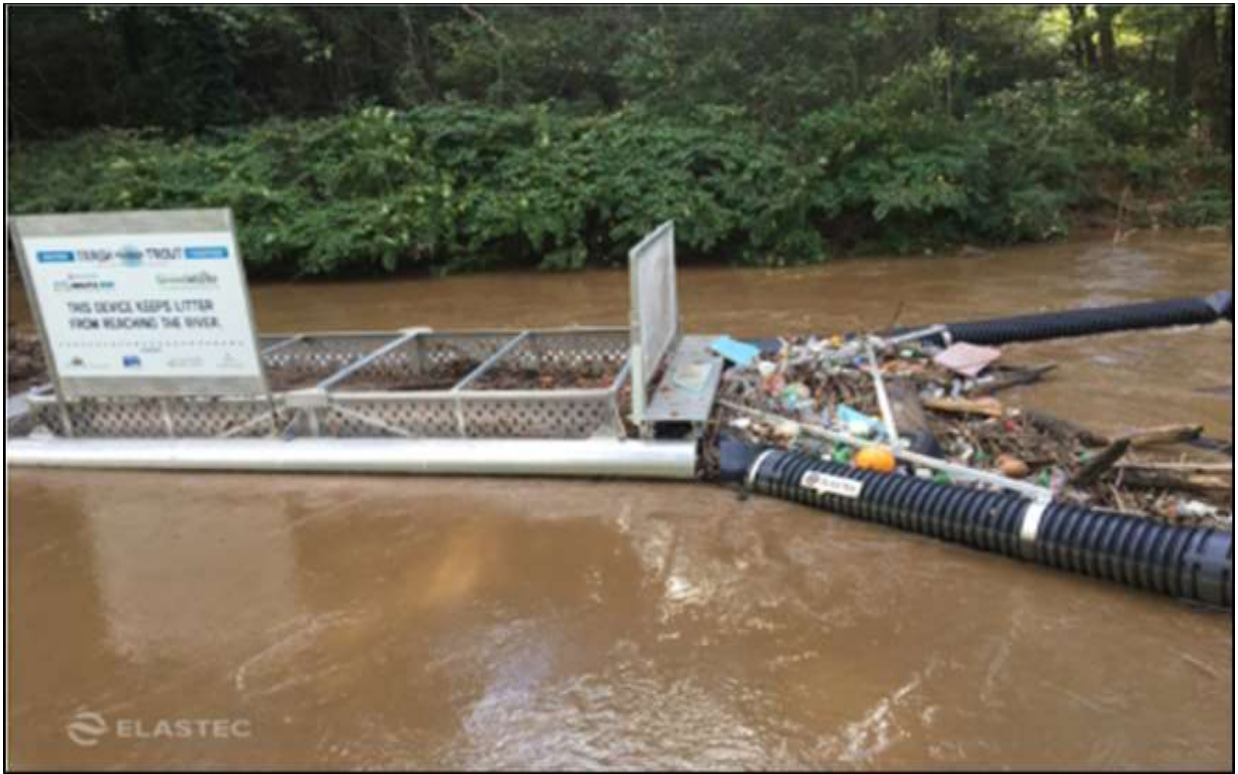
Şekil 35: Drenaj Kanalı Yüzey Temizliği
