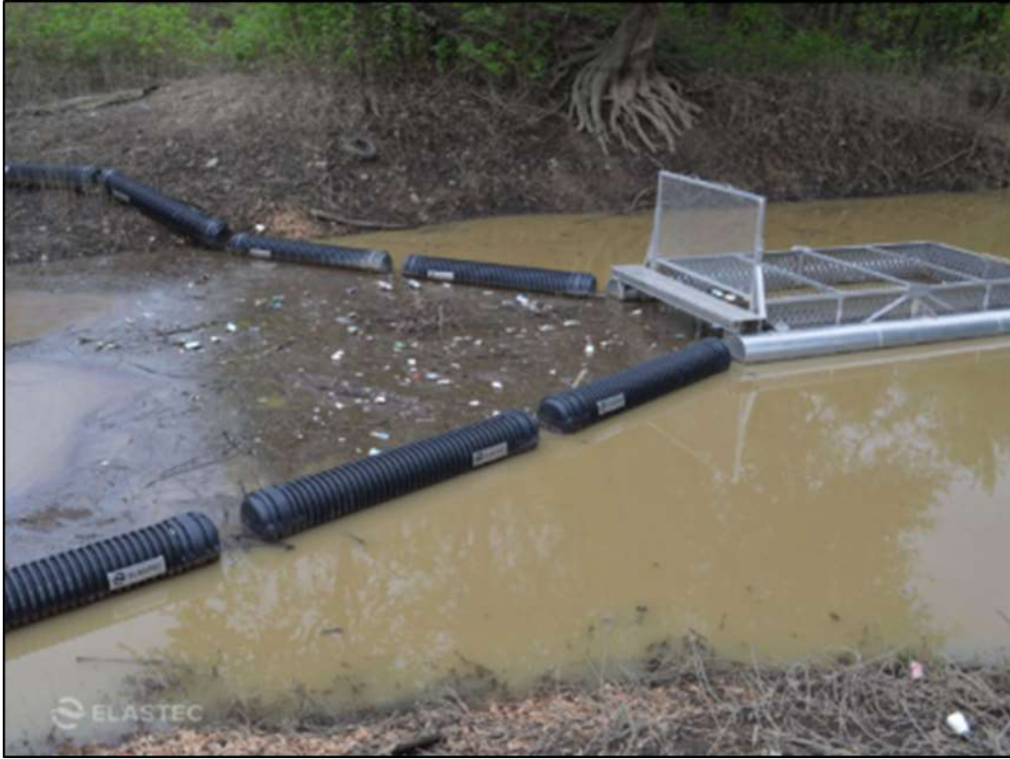
Şekil 34: Drenaj Kanalı Yüzey Temizliği
