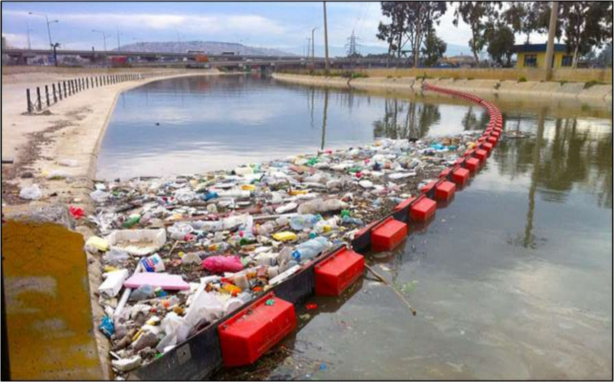
Şekil 33: Sulama Kanalı Yüzey Temizliği
