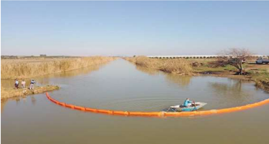
Şekil 22: Bahçe Kanalı Bariyer sistemi
