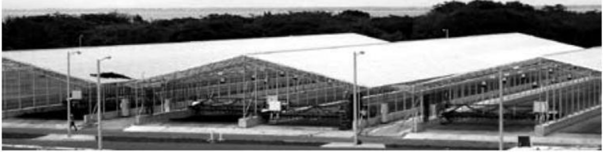
Şekil 11.72: Huber Güneş Kurutma Sistemi (Üstte ve Ortada); İspanya’da Kullanılmakta olan Güneş Kurutma Yataklarının Panoramik Görüntüsü (Altta) (Scharenberg ve Popke, 2010)
