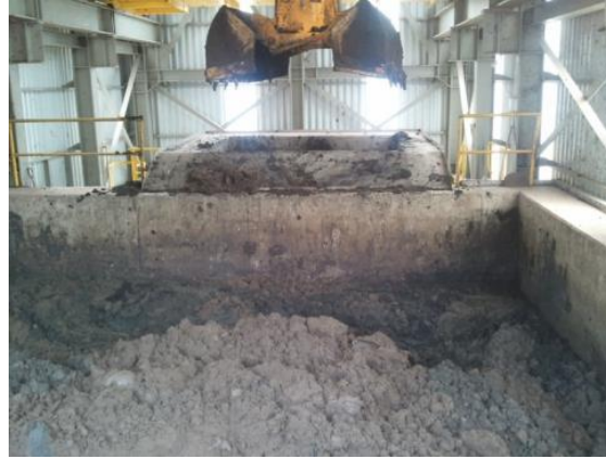
Şekil 11.83: Tesise Gelen Islak Çamurun Kurutucuya Aktarılması
