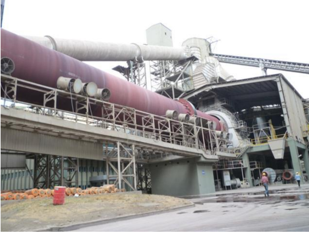
Şekil 11.81: Arıtma Çamurlarının Yakıldığı 3 No'lu Fırın
