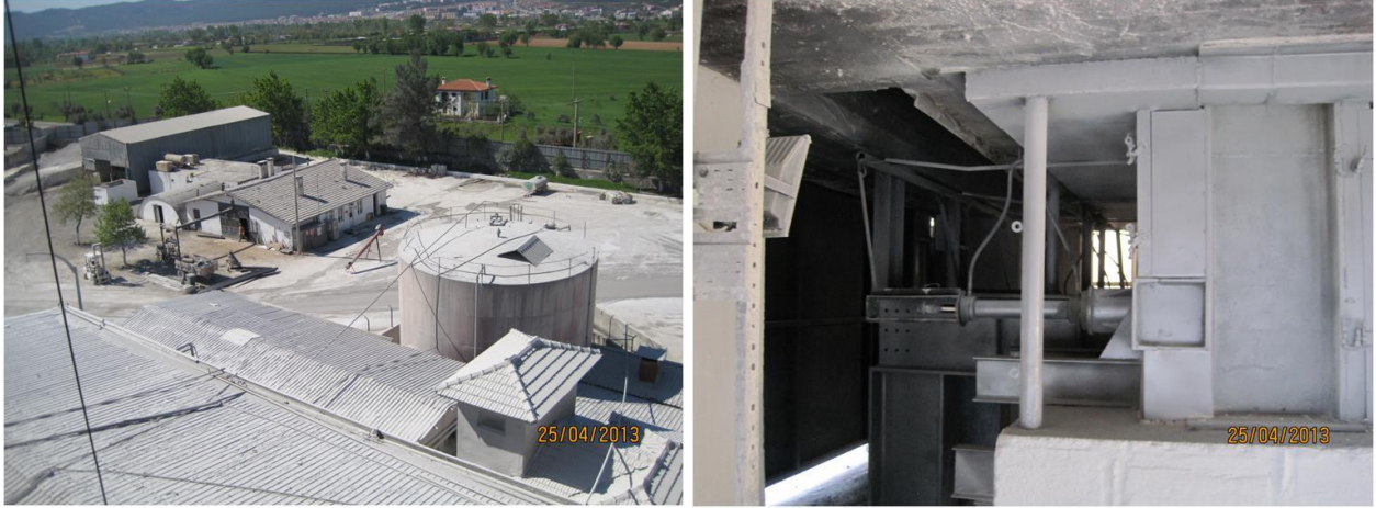
Şekil 11.102: Kireç Üretim Tesisi
