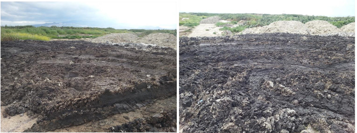
Şekil 11.95: İZSU Çiğli Kentsel Atıksu Tesisi'nden Çamur Kekinin Araziye Serilmesi
