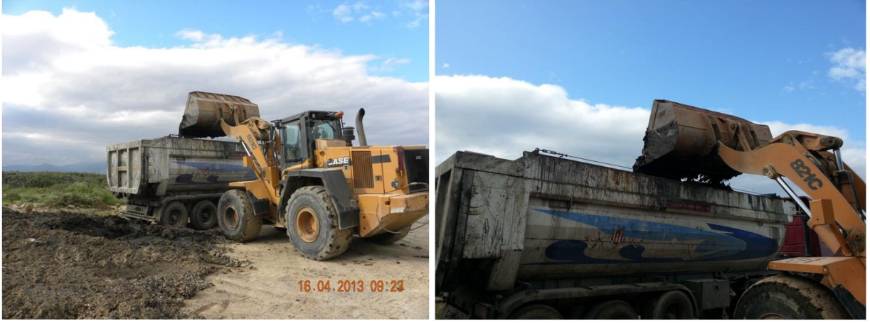
Şekil 11.96: İZSU Çiğli Kentsel Atıksu Tesisi'nden Çamur Kekinın Taşıma Araçlarına Yükleneşesi
