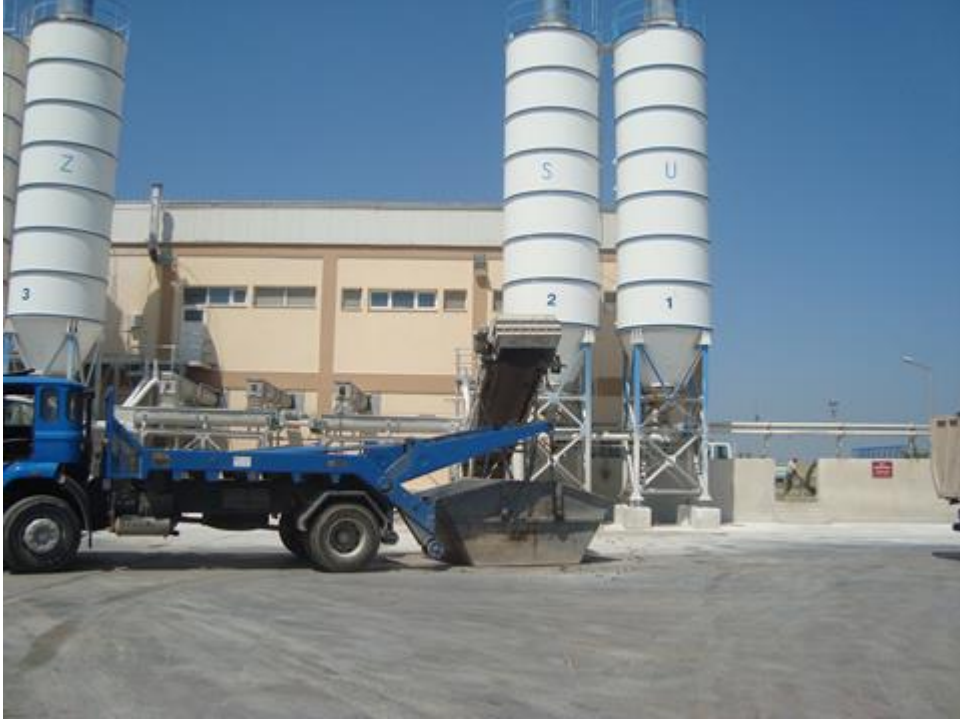
Şekil 10.83 : İZSU Çiğli Arıtma Tesisinden Arıtma Çamurunun Alınışı
