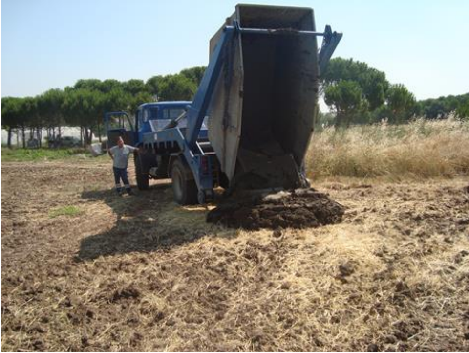
Şekil 10.84 : Arıtma Çamurunun Tarlaya Getirilişi
