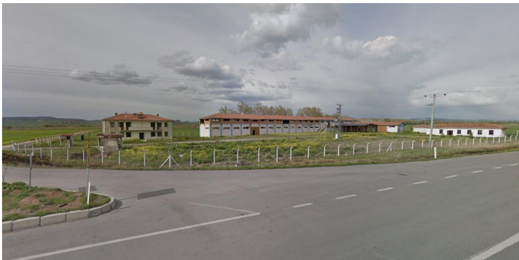
Resim 5: Aşağıbeşpınar Köyü 137 Ada 120 Parselin Mevcut Durumunu Gösteren Fotoğraf
