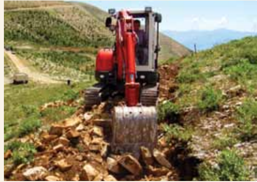
Mini Ekskavatörle Teras
