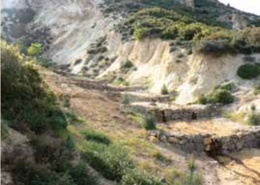
Kuru Duvar Eşik
