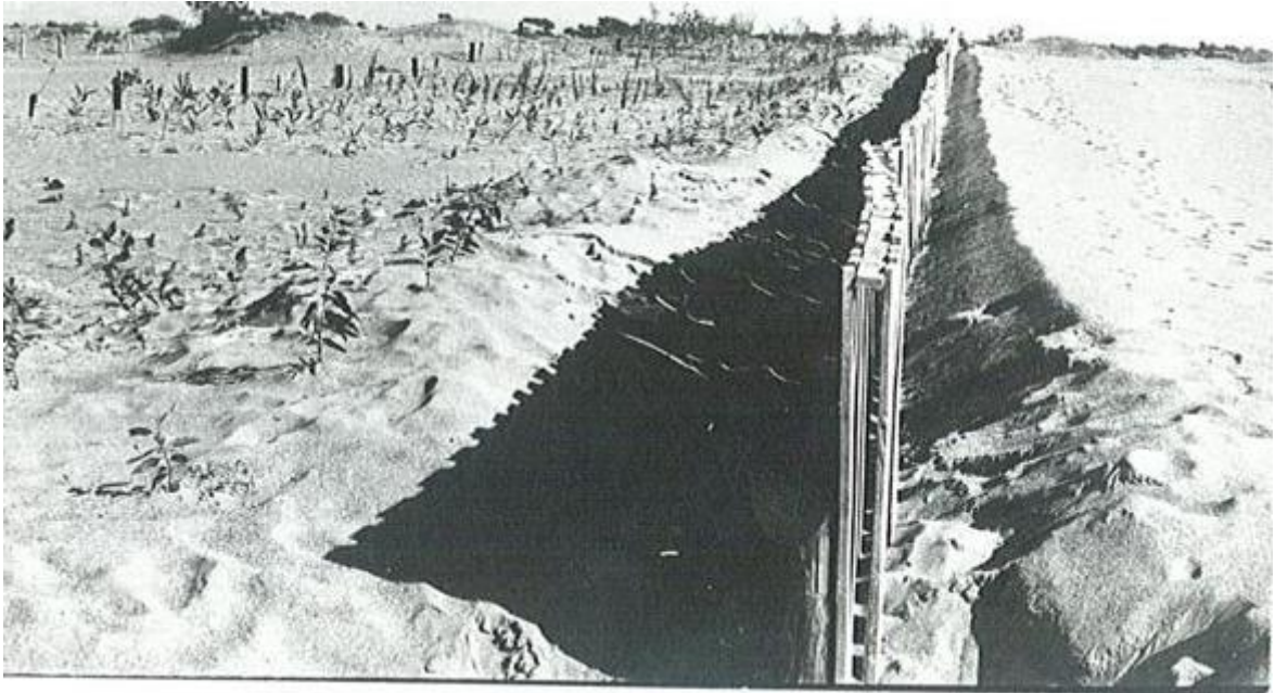
Foto 8: Antalya Belek Kumulunda 1963 yılında yapılan çalışmalar
