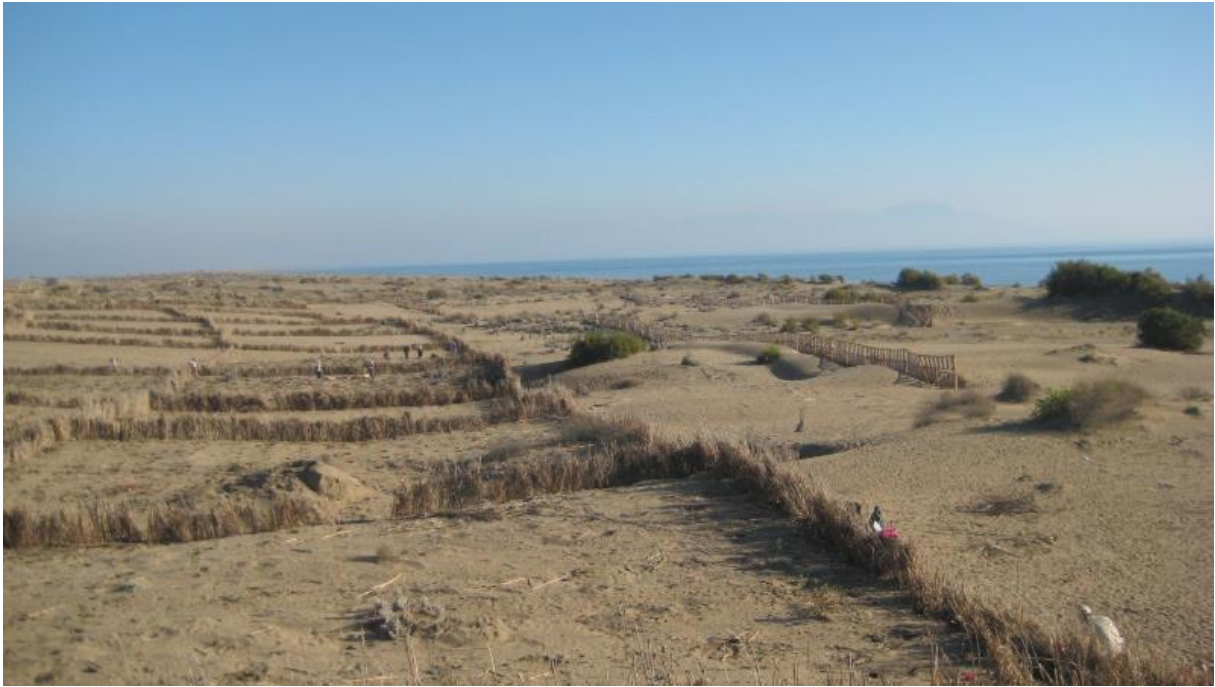
Foto 2: Adana Ağyatan Kumulunda Karelaj Perdeler ve Fidan Dikimleri
