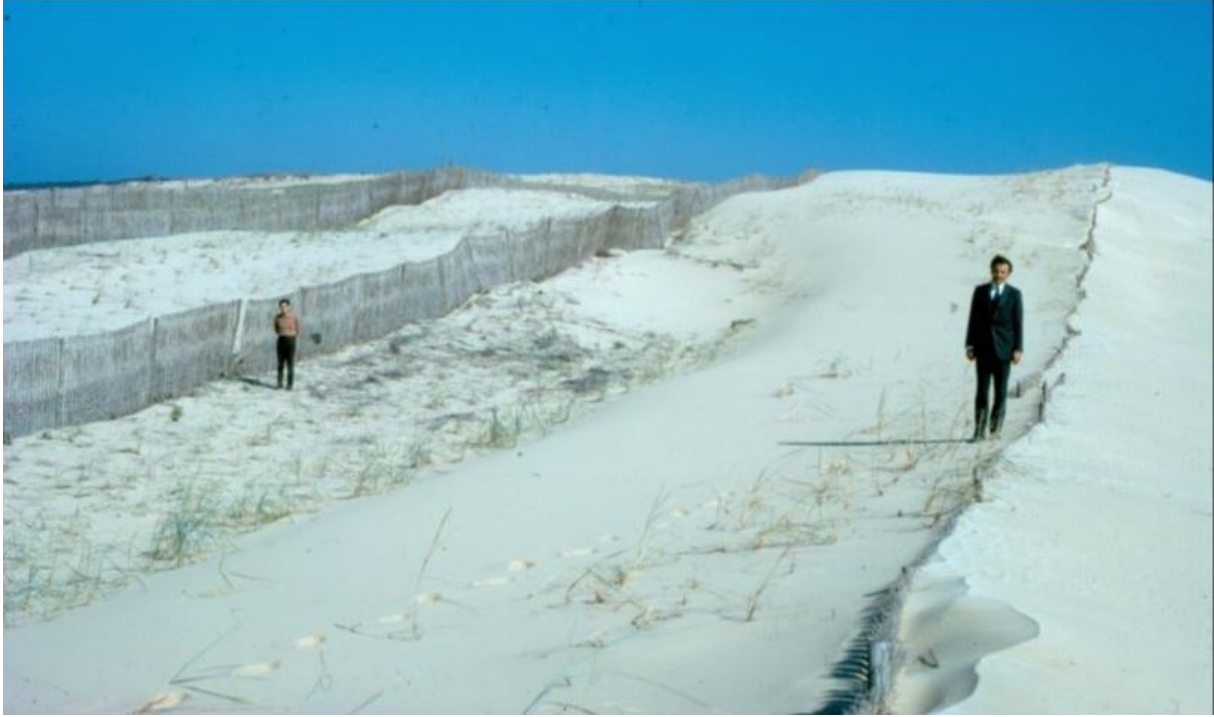
Foto 16: İstanbul-Terkos (Durusu) kumulunda rüzgârın etkisini azaltmak ve kumulların hareketini yavaşlatmak için oluşturulmuş rüzgâr kırıcıları (Saatçioğlu ve Ark., 1978) (Fotoğraf Silvikültür Anabilim Dalı arşivinden)
