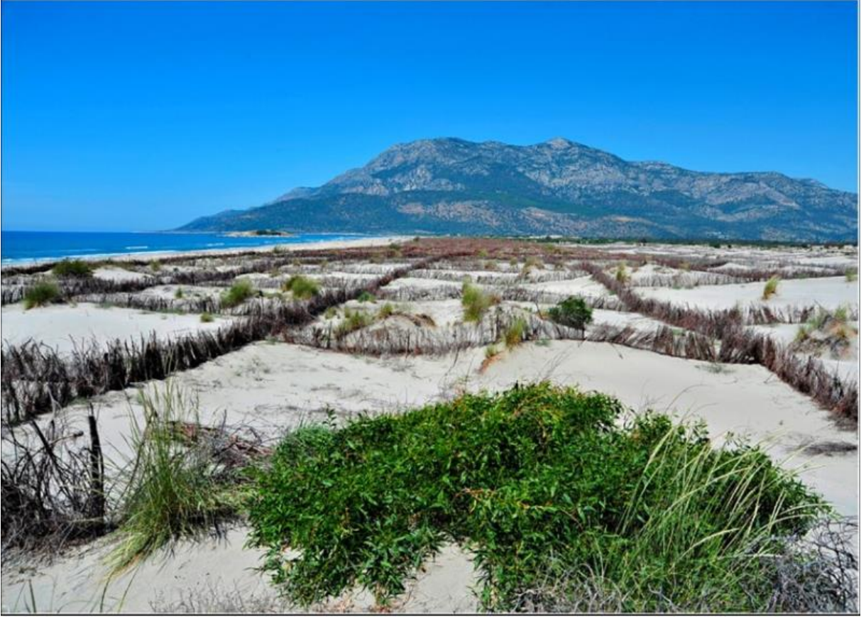
Foto 11: Muğla-Fethiye-Kumluova kumulunda çalı demetleri ile oluşturulan rüzgâr kırıcıları (Foto: M. Demirbaş)
