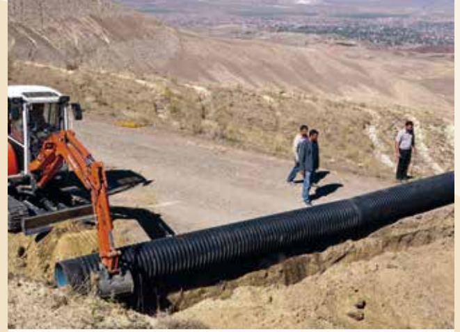
Yollara Koruge Boru Yerleştirilmiştir.
