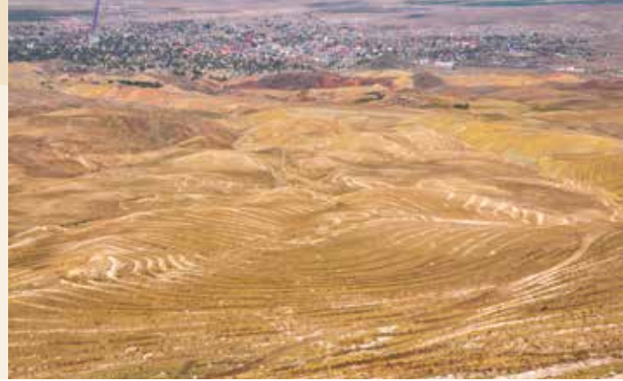
Uygun Sahalarda Emdirici Terasla Yamaç Islahı. Toprak Taşınmasının Önlenmesi Amacıyla Meyilli Dik Sahalar Teraslanmıştır.
