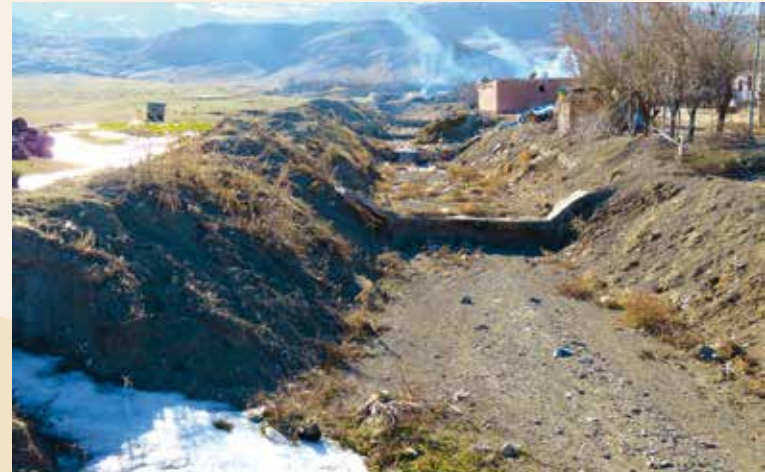
Dere yatağında/mecrada sistemantik olarak yapılmış ıslah sekileri ve taban kuşakları
