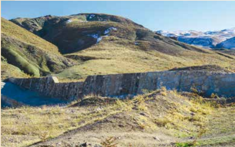
Dere yatağında/mecrada sistemantik olarak yapılmış ıslah sekileri ve taban kuşakları
