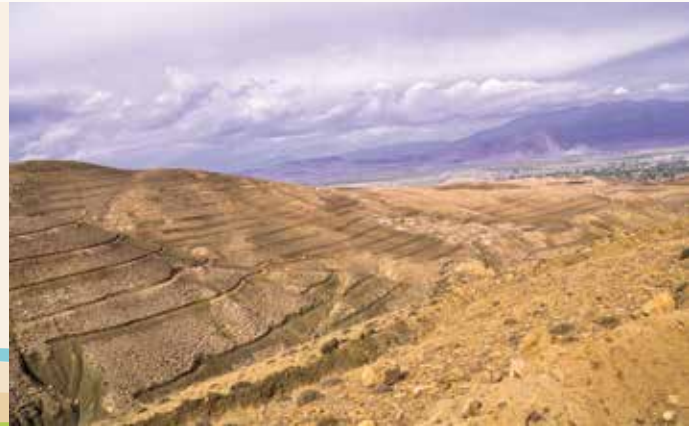
Uygun Sahalarda Emdirici Terasla Yamaç Islahı. Toprak Taşınmasının Önlenmesi Amacıyla Meyilli Dik Sahalar Teraslanmıştır.
