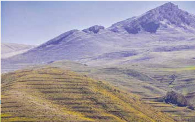
Uygun Sahalarda Emdirici Terasla Yamaç Islahı. Toprak Taşınmasının Önlenmesi Amacıyla Meyilli Dik Sahalar Teraslanmıştır.
