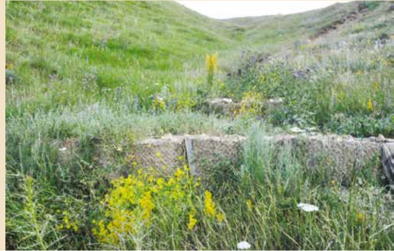
Kafes tel çitlerin arkası taşınan rusubatla dolmuş, otlanmış ve stabilize sağlanmış oyuntular.
