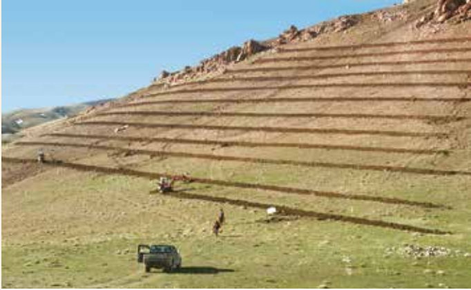
Uygun Sahalarda Emdirici Terasla Yamaç Islahı. Toprak Taşınmasının Önlenmesi Amacıyla Meyilli Dik Sahalar Teraslanmıştır.
