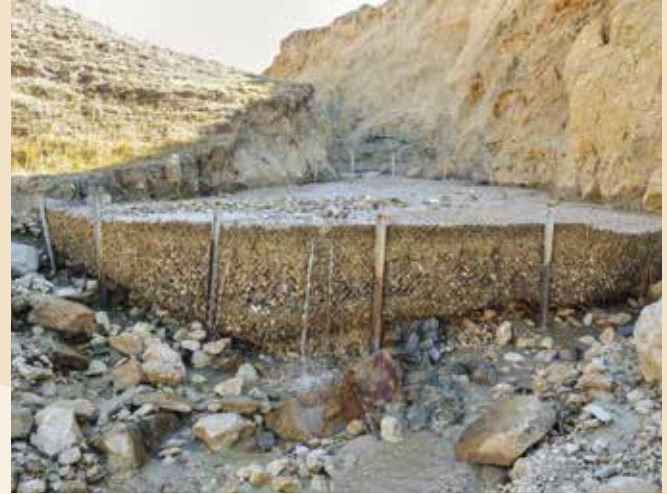
Sistemik Kafes Tel Eşik Tesisleriyle Oyuntularda Toprak Taşınması Önlenmiştir.
