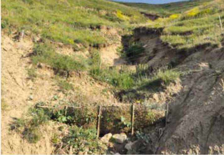
Sistemik Kafes Tel Eşik Tesisleriyle Oyuntularda Toprak Taşınması Önlenmiştir.
