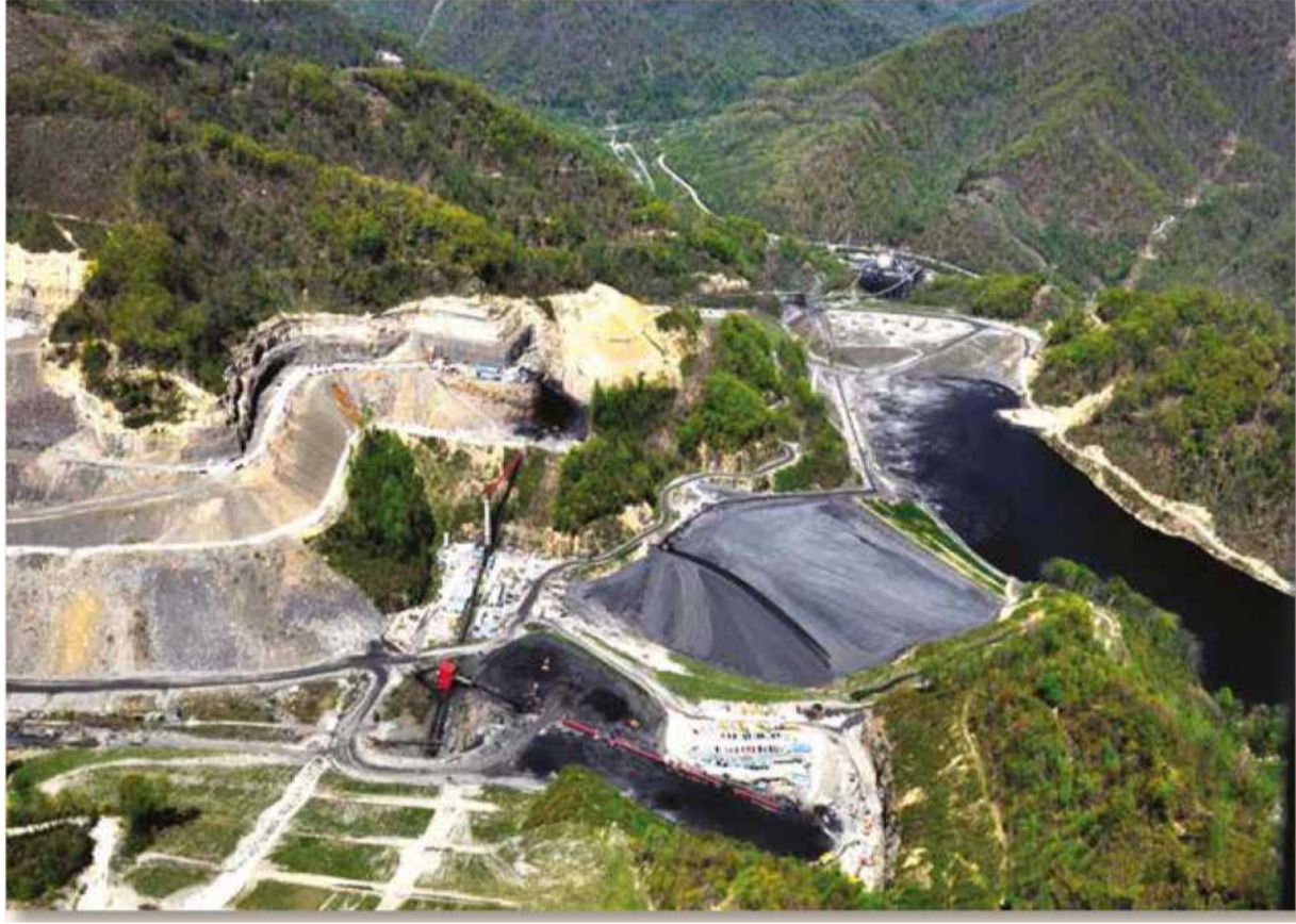
Resim 11. Kapalı Ocak Madenciliği ve Pasa Döküm Sahası, Batı Virjinya Kömür İşletmesi – ABD
