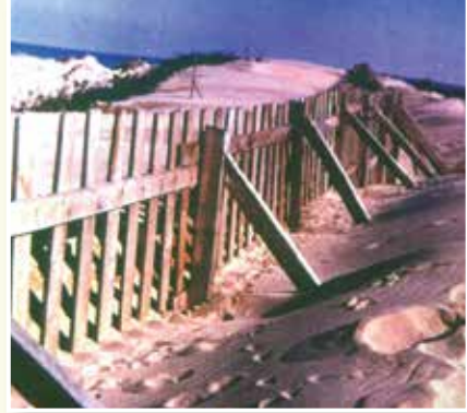
Fotoğraf 5-48 Kumul Hareketinin Önlenmesi
