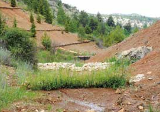
Fotoğraf 5-29 Örme Canlı Eşik ile Oyuntu Islahı
