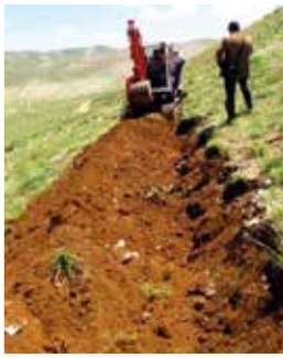
Fotoğraf 5-9 Mini Ekskavatörle Toprak İşleme
