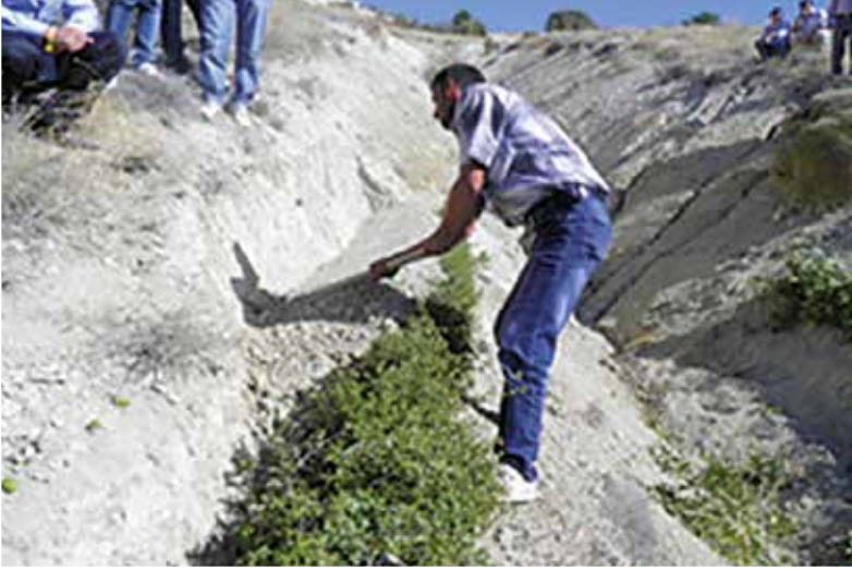
Fotoğraf 5-16 Çalı Demetli Teras
