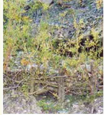
Fotoğraf 5-29 Örme Canlı Eşik ile Oyuntu Islahı
