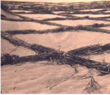
Fotoğraf 5-48 Kumul Hareketinin Önlenmesi
