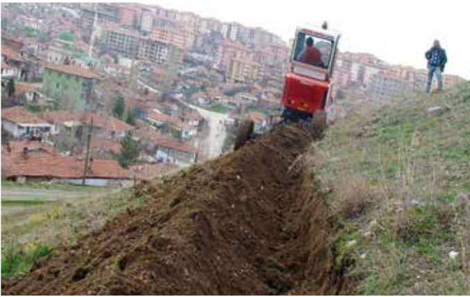
Fotoğraf 5-10 Örümcek Ekskavatörle Toprak İşleme
