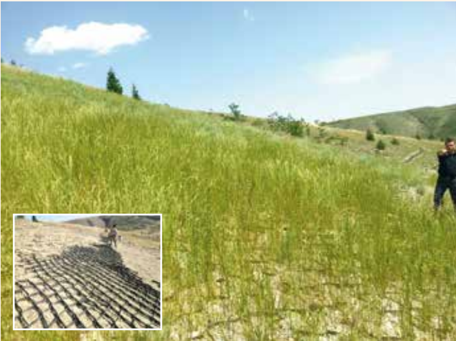
Geotekstil Yüzey kaplaması ve otlandırma
