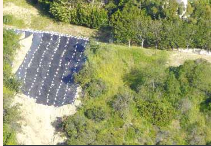
Geotekstil yüzey kaplaması
