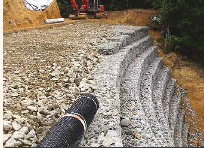
Geotekstil takviyeli Gabion teras duvar
