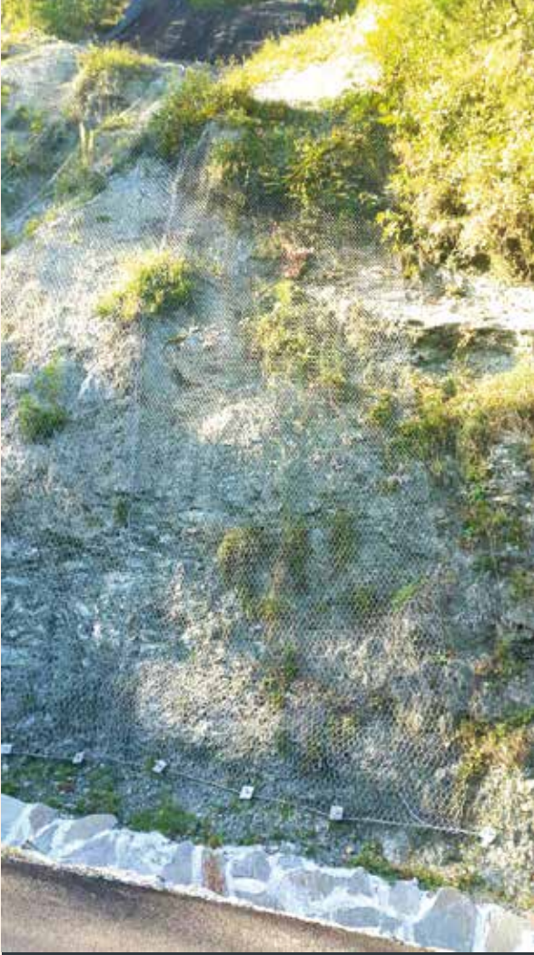
Çelik kafes tel ile yüzey kaplaması
