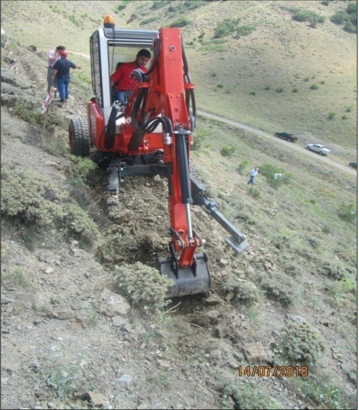
Örümcek tipi ekskavatörle teras
