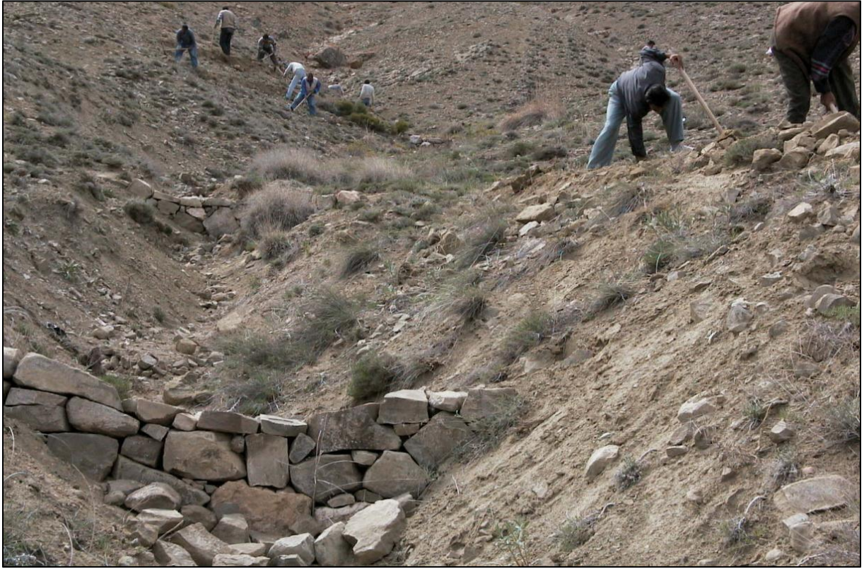
Kuru Duvar Eşik
