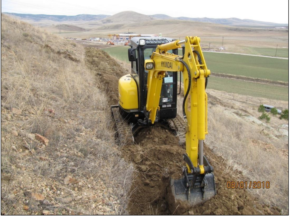
Mini ekskavatörle Teras
