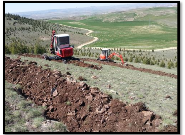
BUROR Tipi Teras (100-120cm Genişlikte)
