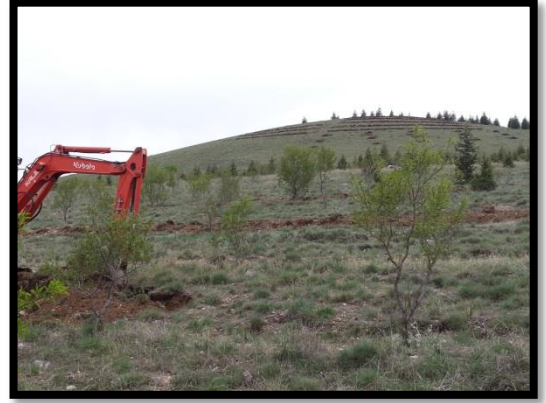
Şekil . Proje alanı mini ekskavatör BUROR ve örümcek teras ile BUROR toprak işleme
