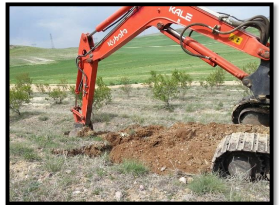
BUROR Tipi Teras (120-150cm Genişlikte)
