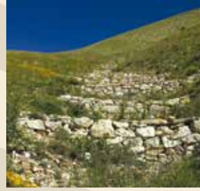
Kuru Duvar Eşik
