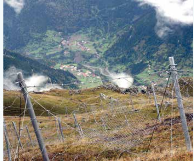
Çığ kontrolü çalışmaları (Trabzon-Uzungöl)
