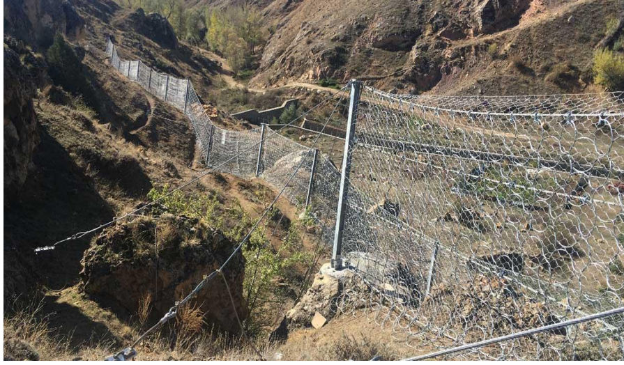
Şekil 4. Kaya Düşmesi Kontrol Yapılarından Çelik Bariyer / Kaya Tutucu Bariyer Uygulamasına Bir Örnek
