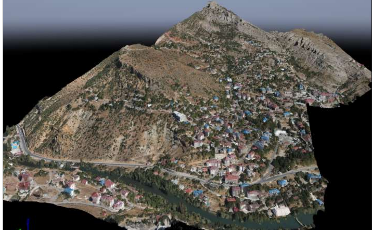
Tunceli Merkez Alibaba Mevkii Kaya Düşmesi Projesi Kapsamında Kaya Kaynak Noktalarındaki Hat Etütleri ve İnsansız Hava Aracı İle Oluşturulan Arazi Modeli
