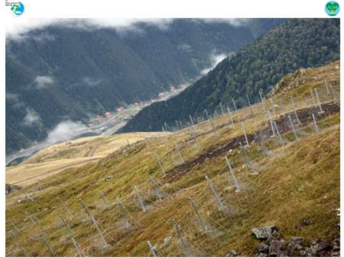
Çiğ Kontrolü Çalışmaları Üzungöl - Trabzon
