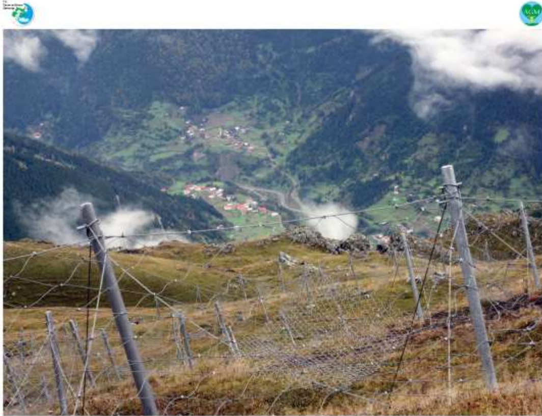
Çiğ Kontrolü Çalışmaları Üzungöl - Trabzon
