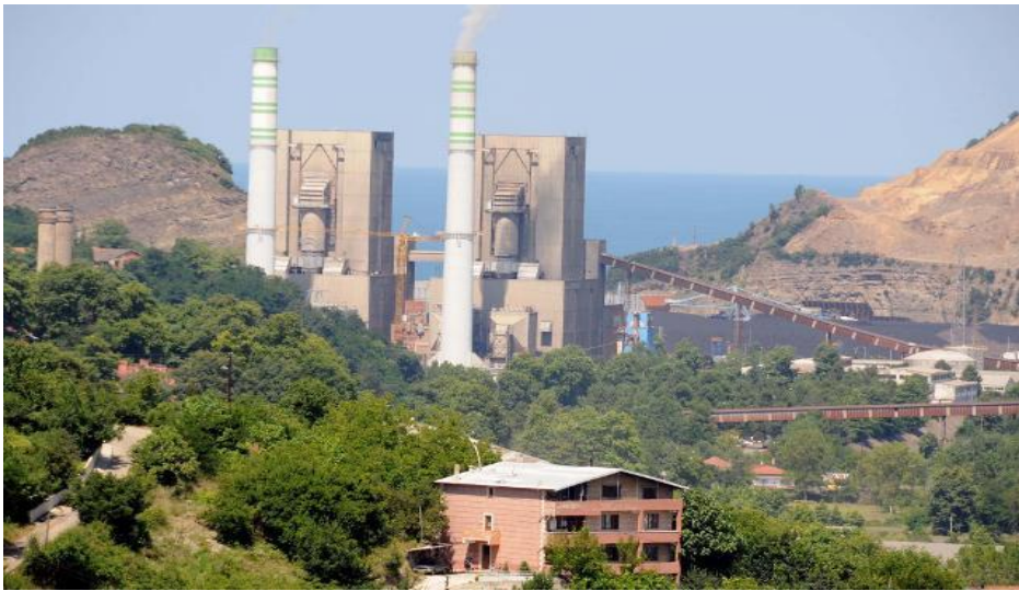
Şekil C.15 –Zonguldak ilinde bulunan EREN ENERJİ ve ÇATES Termik Santralleri
