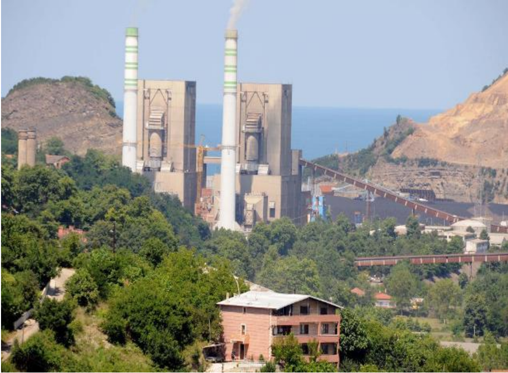
Resim C.1 – Zonguldak İli Kilimli İlçesinde bulunan Eren Enerji Elektrik Üretim A.Ş. ve Çates Elektrik Üretim A.Ş. Termik Santralleri (ZÇŞİM, 2019)
