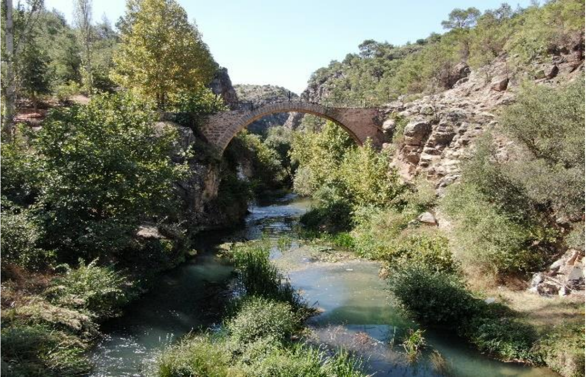
Resim D.17- Clandras Köprüsü
