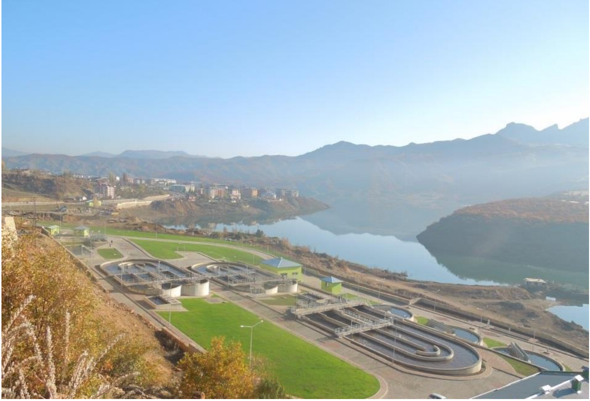
Resim B.1 - Atıksu Arıtma Tesisi Genel Görünüm
