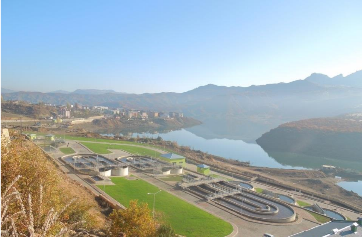
Resim B.1 - Atıksu Arıtma Tesisi genel görünüm.
