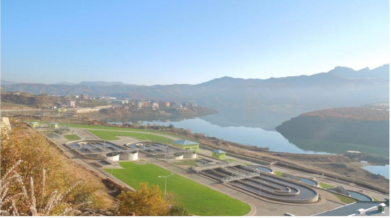
Resim 1- Atıksu Arıtma Tesisi Genel Görünüm
