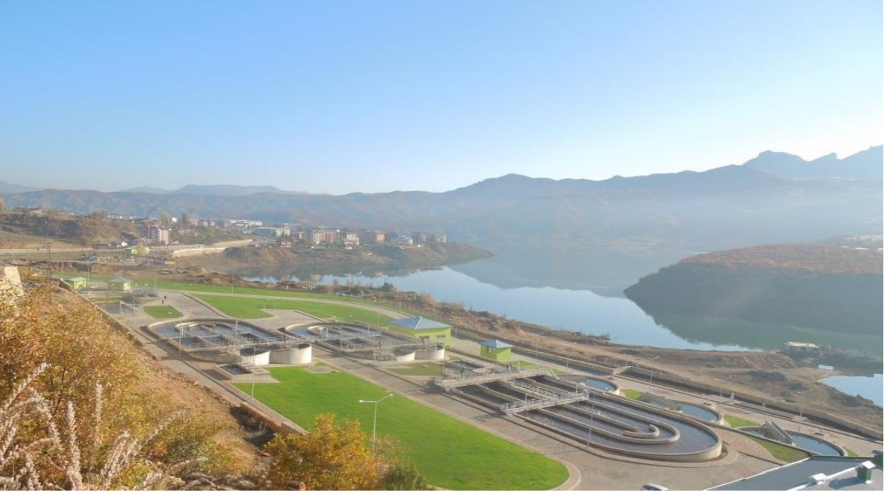
Resim 1- Atıksu Arıtma Tesisi Genel Görünüm
