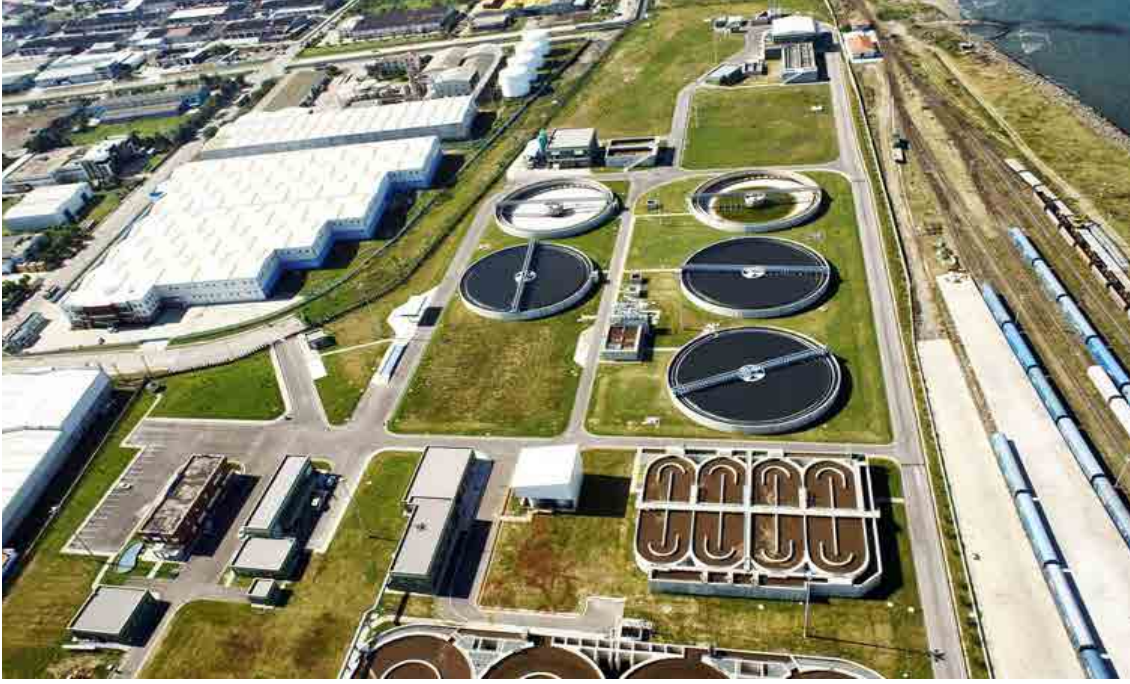
Fotoğraf 1– Samsun Doğu Atıksu Arıtma Tesisi (Çevre ve Şehircilik Bakanlığı, 2016)
