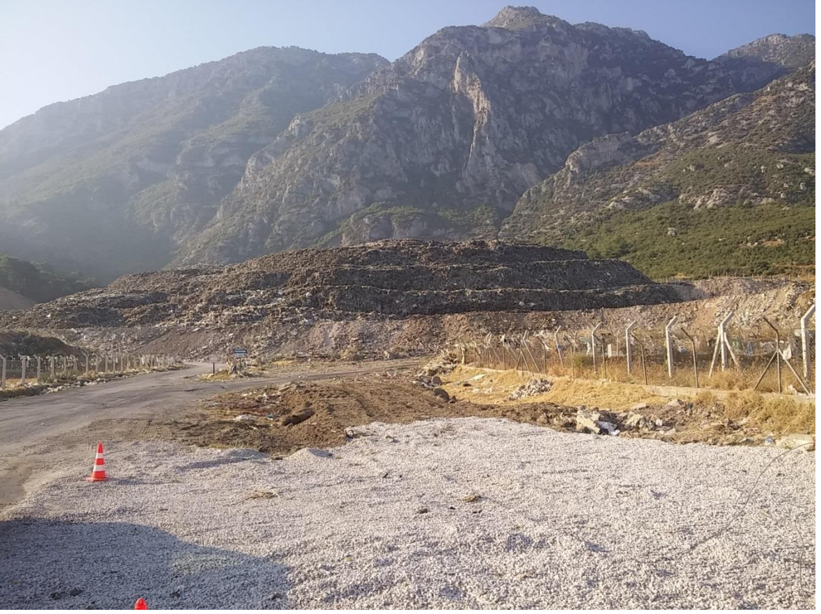
Resim-1: Şehzadeler İlçesi Kırtık Mevkiinde Yer Alan Düzensiz Depolama Sahası
