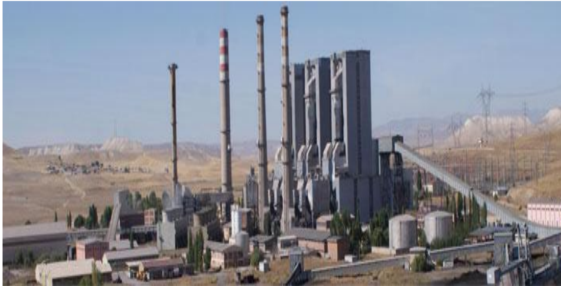
Resim C.2- Termik Santral (Termik Santral İşletmecisi, 2023)
